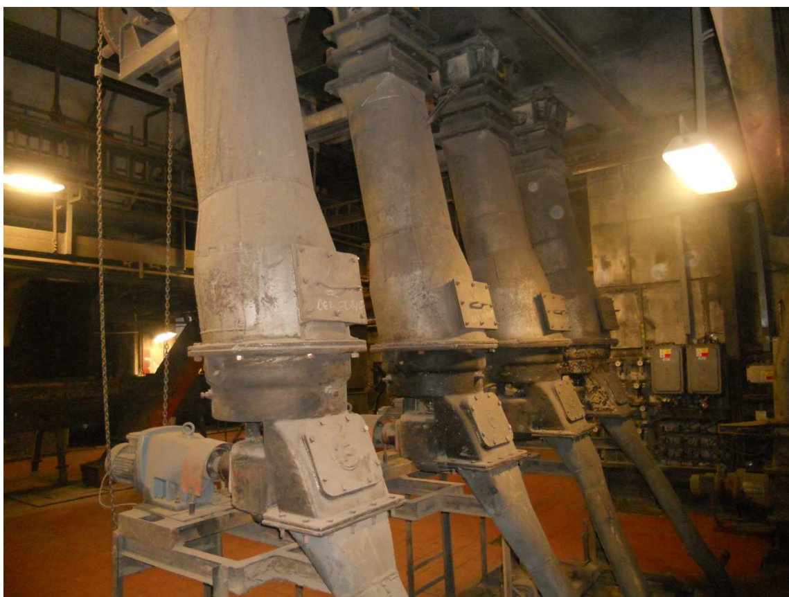
Obr. 3 Výsypky zásobníku uhelného prášku
