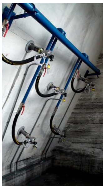
Obr. 11 Aplikace rozvodu tlakového vzduchu na betonové stěně zásobníku [17]
