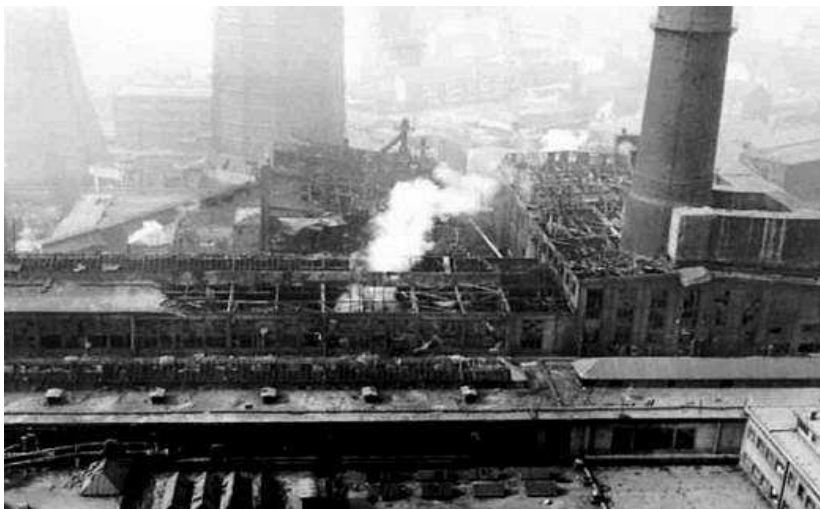
Obr. 15 Výbuch kotelny teplárny Špitálka [20]
