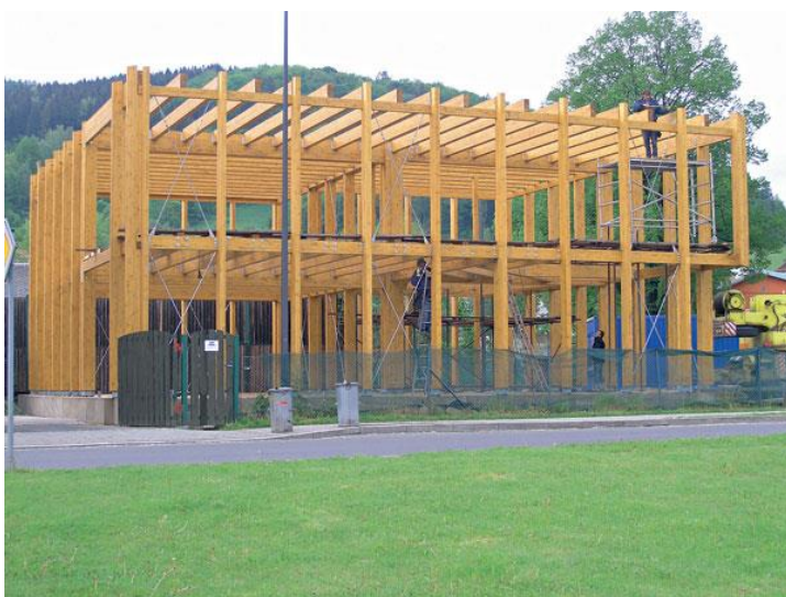
Obr. 3 Příklad drevenej skeletovej konštrukcie
