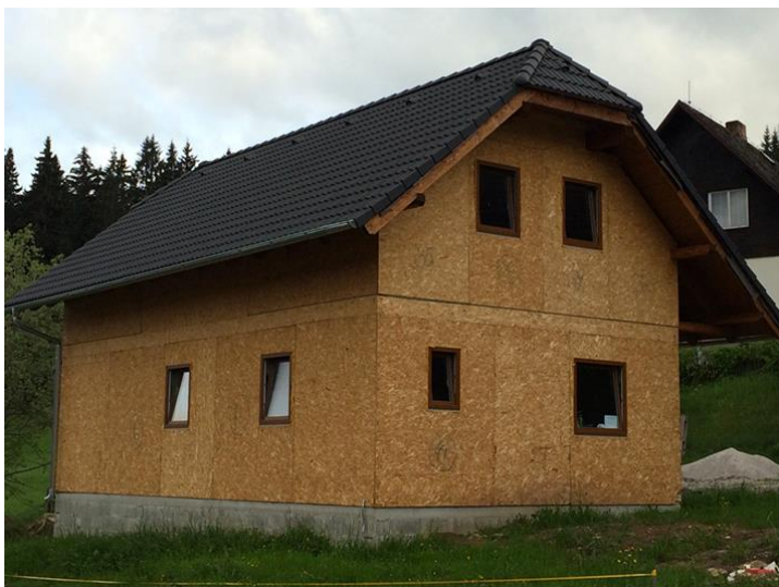
Obr. 2 Drevená rámová konštrukcia opláštená OSB doskami
