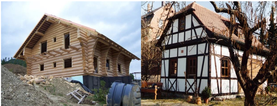
Obr. 1 Porovnanie zrubovej (vľavo) a hrázdenej stavby (vpravo)
