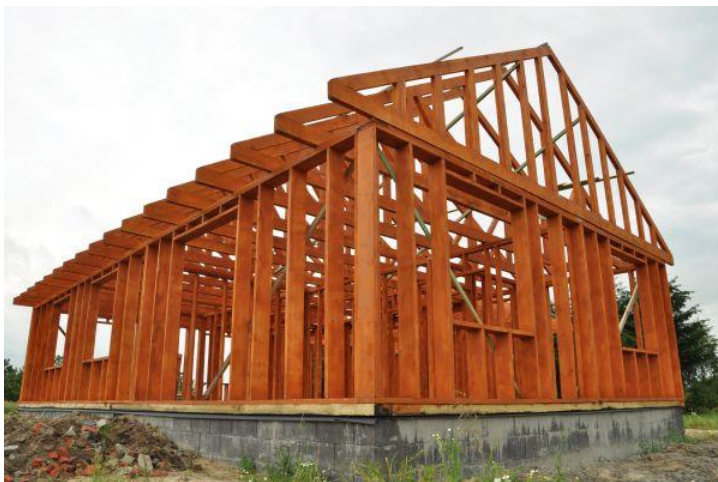
Obr. 2 Drevená rámová konštrukcia bez opláštenia
