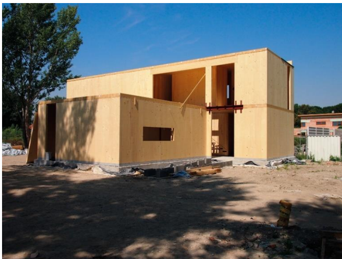
Obr. 12 Nosná konštrukcia z panelov z krížom lepeného dreva
