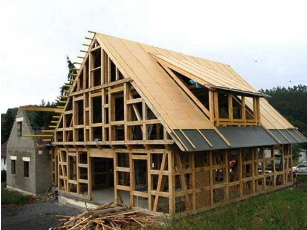
Obr. 7 Odhalená drevená konštrukcia hrazdenej stavby
