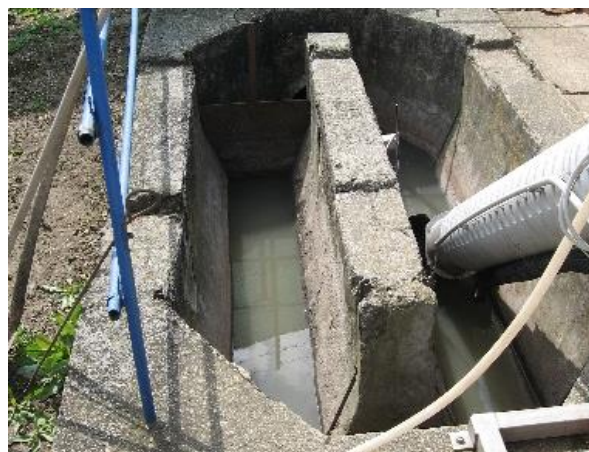
Obr. 6.2-30 ČOV H - Gravitační přítok
