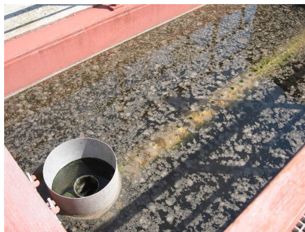
Obr. 6.2-28 ČOV G - Ponořený odtok z dosazovací nádrže
