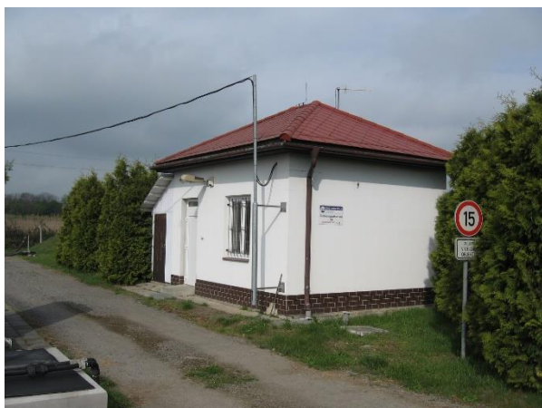
Obr. 6.2-5 ČOV B - Provozní budova
