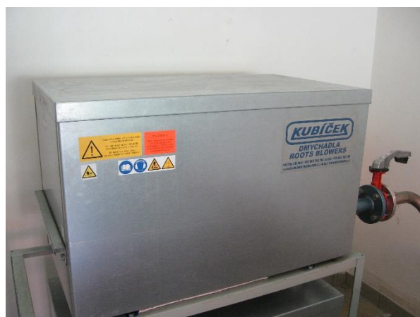
Obr. 6.2-10 ČOV C - Ukázka dmychadla
