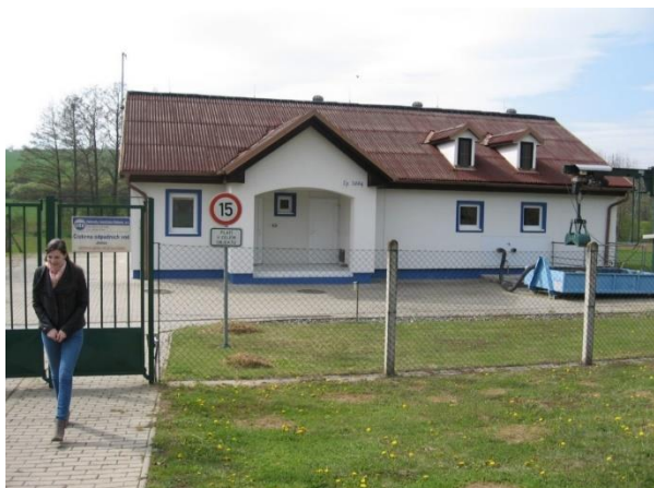
Obr. 6.2-13 ČOV D - Pohled na čistírnu
