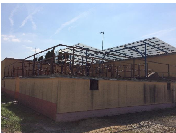
Obr. 6.2-25 ČOV G - Pohled na čistírnu
