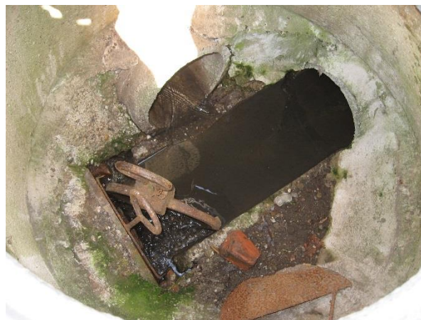
Obr. 6.2-18 ČOV E - Přítok na čistírnu s odlehčením
