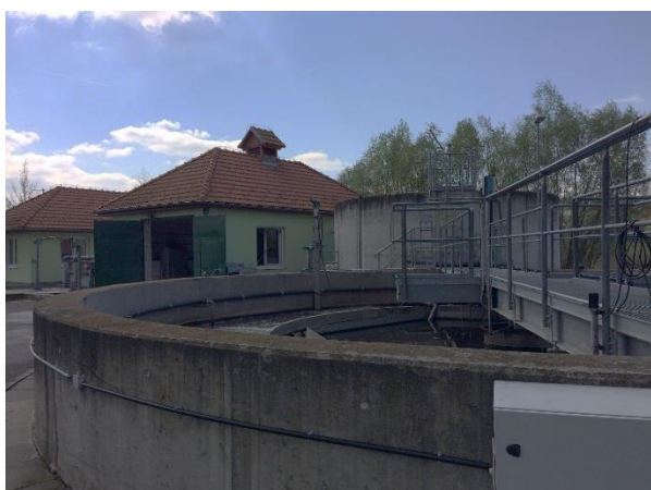
Obr. 6.2-9 ČOV C - Pohled na čistírnu
