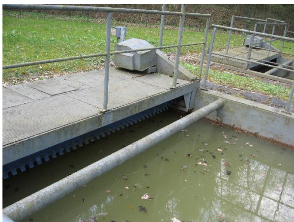
Obr. 6.2-19 ČOV E - Systém Kessener
