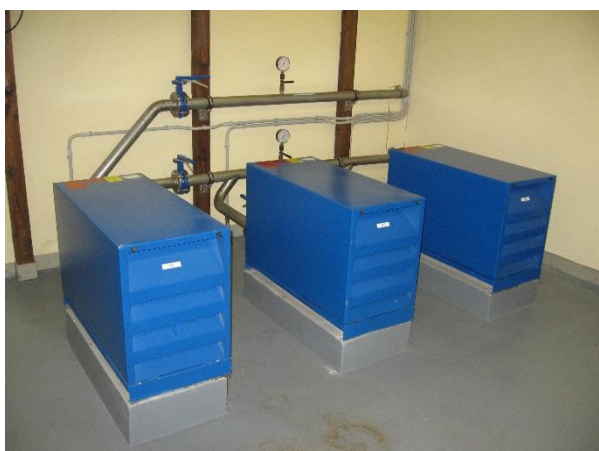
Obr. 6.2-15 ČOV D - Dmyhadla
