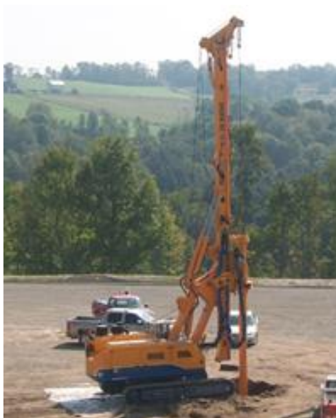
Obrázek 30: Vrtná souprava velko-průměrových pilot Bauer BG 12 H [24]
