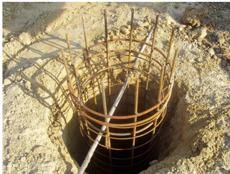
Obrázek 9: Ustanovení armokoše ve vrtu piloty [9]
