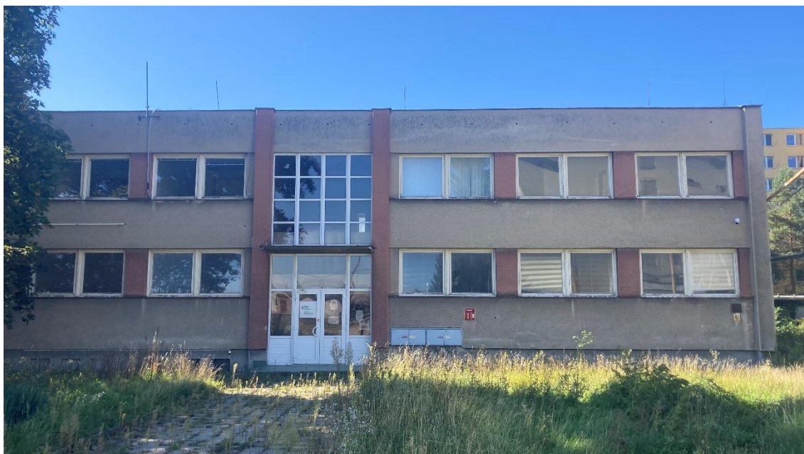
Obrázek 2 Přední pohled stavu budovy před rekonstrukcí (Zdroj: Vlastní foto)
