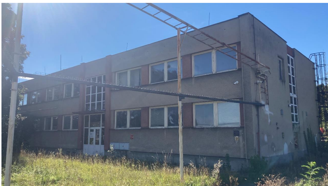
Obrázek 3 Boční pohled stavu budovy před rekonstrukcí (Zdroj: Vlastní foto)
