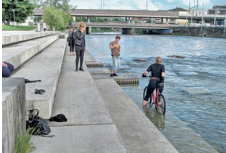
Obrázek 22 – Pobytové schody v Curychu. [9]
