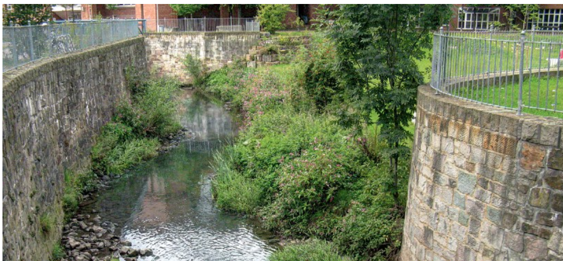
Obrázek 19 - Členění dna v úzkém korytě v Německu. [9]
