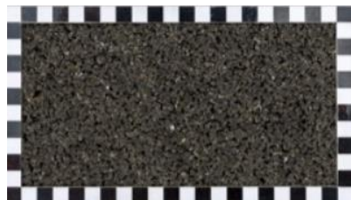
Obr. 9 Tenký asfaltový povrch (VTAC) 0/4 [20]
