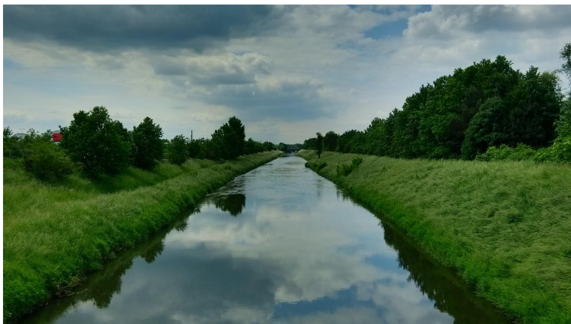
Obr. 9.8c Pohled na ohrazované koryto směrem k modřické ČOV (Soutok)
