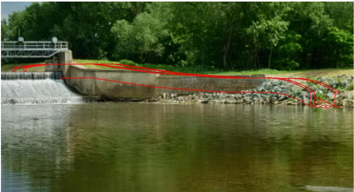
Obr. 9.7b Jez Přížrenice – Návrh možného umístění rybiho přechodu
