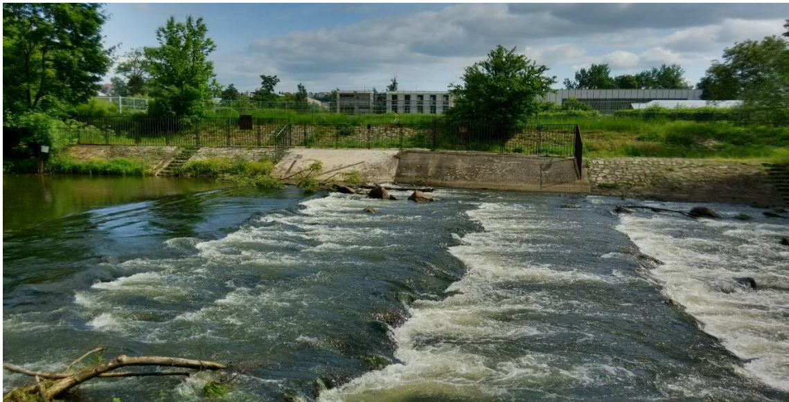
Obr. 9.5a Bývalý vakový jez Riviéra je v současnosti migračně prostupný (Staré Brno)
