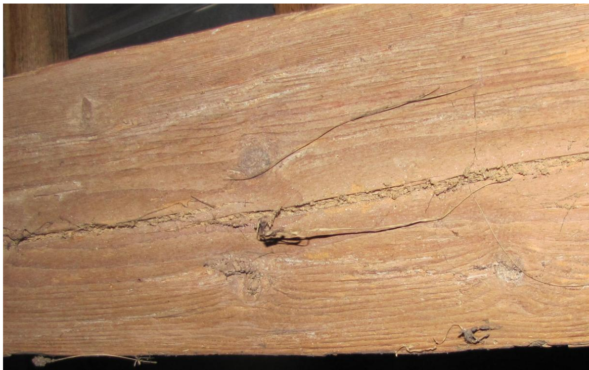
Obr. 5.33: Levá krokev – požerky od červotoče, plíseň
