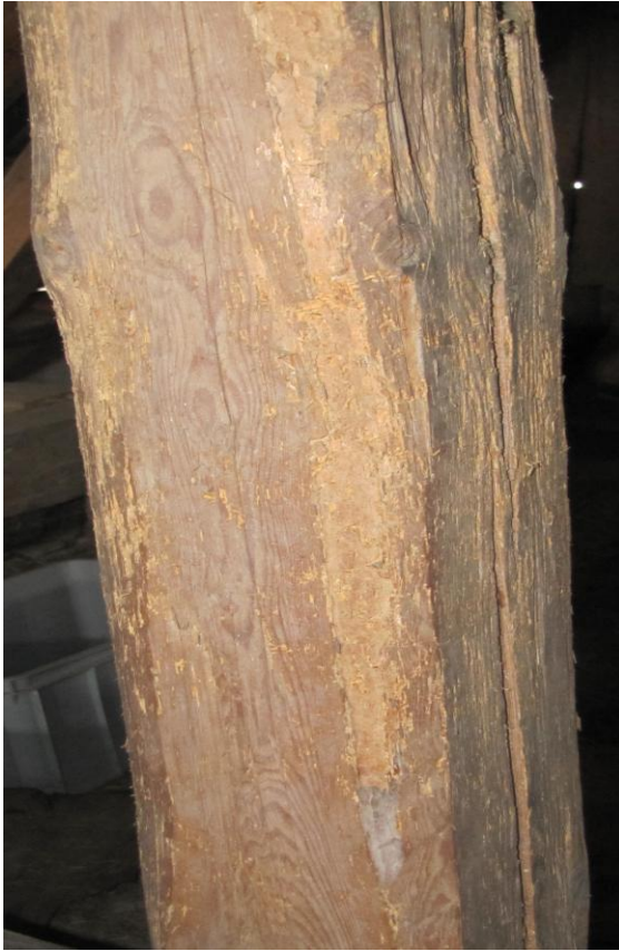
Obr. 5.36: Sloupek zničený červotočem
