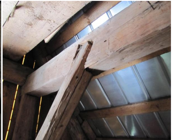
Obr. 5.13: Pravý pásek - pootočení
