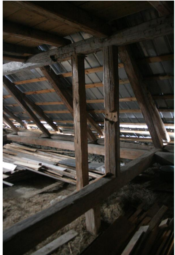
Obr. 5.37: Na fotografii vidíme sloupek s bývalým tesařským spojem pro upevnění pásků a přidělanou podporu
