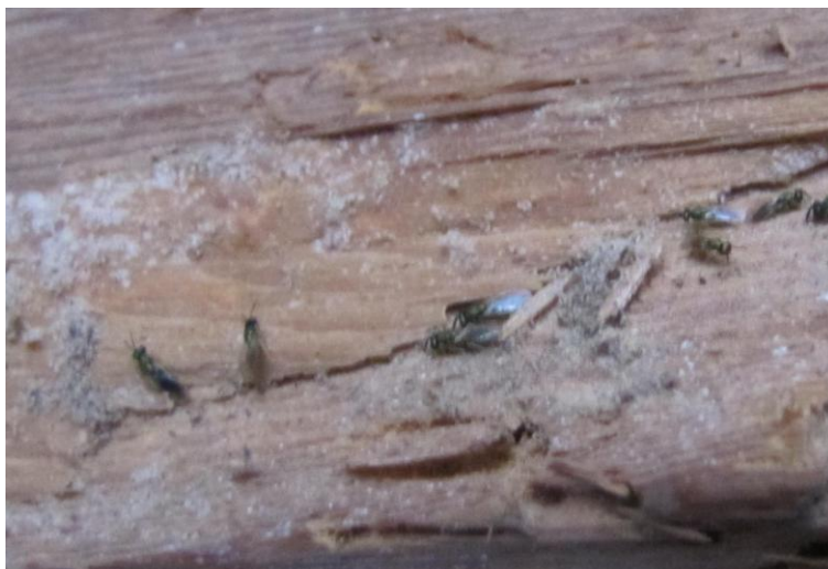
Obr. 5.41: Požerky červotoče na sloupku
