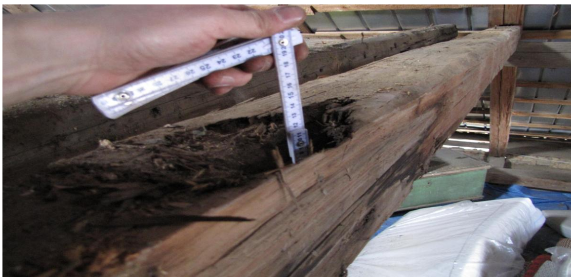
Obr. 5.20: Kostkovitý rozpad dřeva vlivem hniloby
