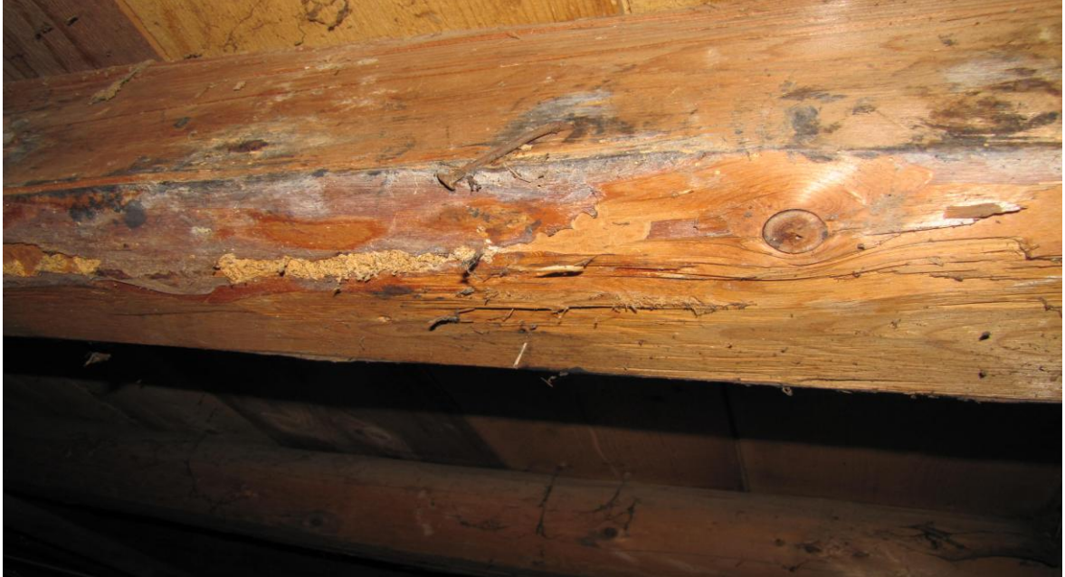
Obr. 5.28: Hambálek napadený plísní (bílé skvrny) a tesaříkem (požerky)
