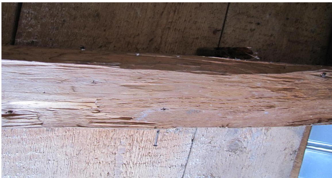
Obr. 5.17: Plíseň na hambálku (bílé skvrny)
