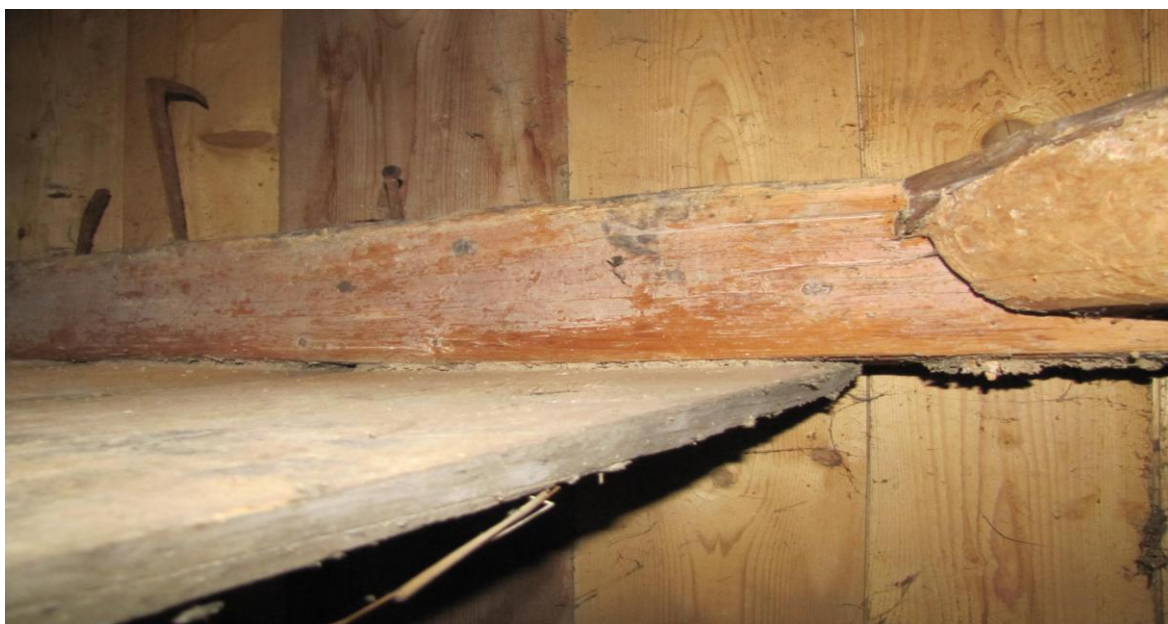
Obr. 5.31: Hambálek napaden plísní od dřevěných desek (v levé části je vidět příčka)
