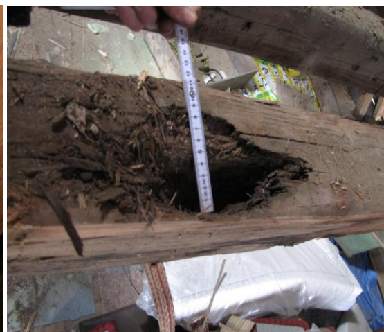
Obr. 5.19: Kostkovitý rozpad dřeva
