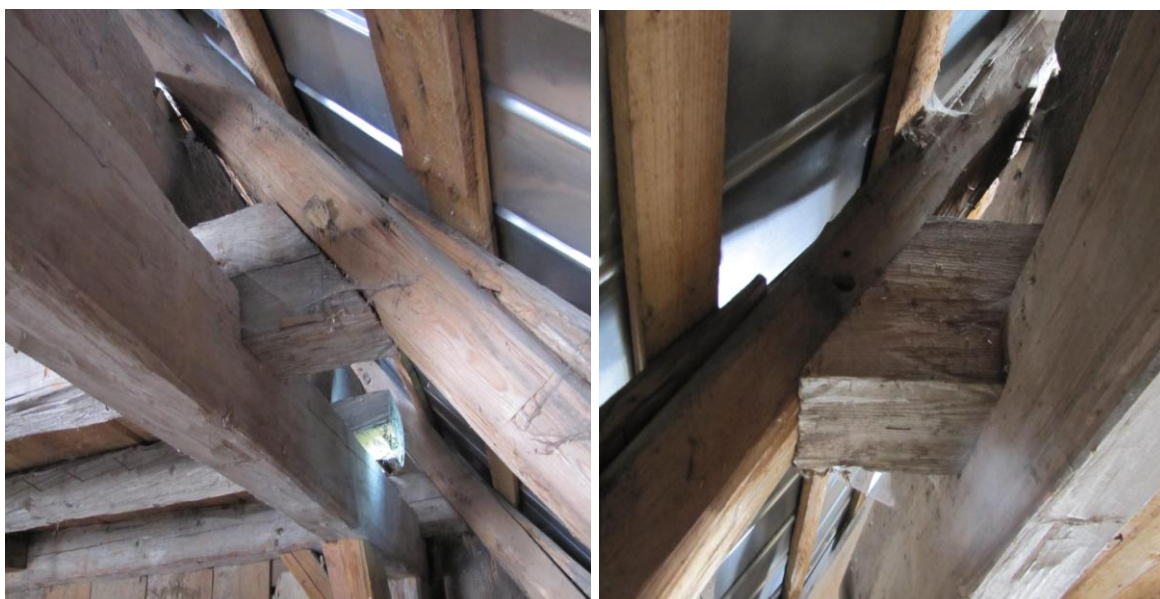
Obr. 5.22 a 5.23: Vysunutý kolík při pohledu směrem na sever a jih
