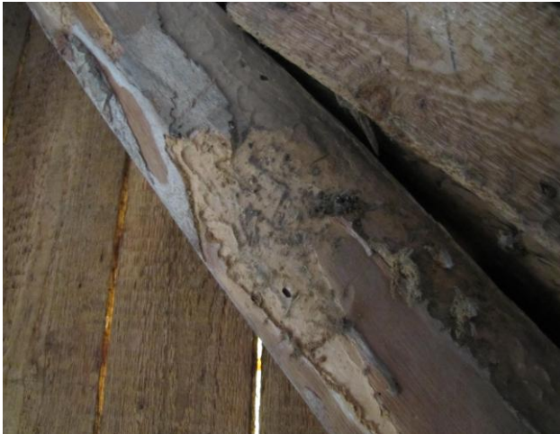
Obr. 5.12: Pravá krokev – výletové otvory od tesaříka
