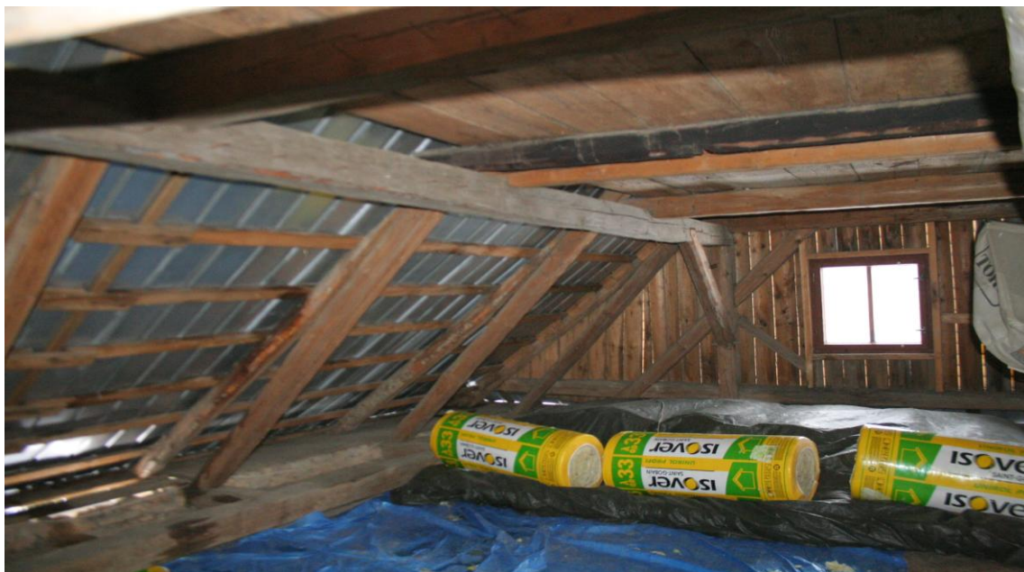
Obr. 5.5: Pohled na konstrukci krovu (jižní strana). První vazba plná, následující tři vazby prázdné
