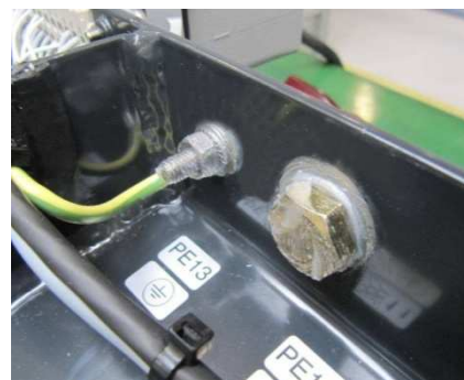
Obr. 21 Kontrola konzervování zemních šroubů
