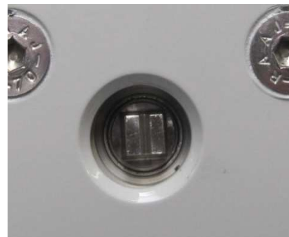
Obr. 39 Ovládací čtyřhran zamykací jednotky
