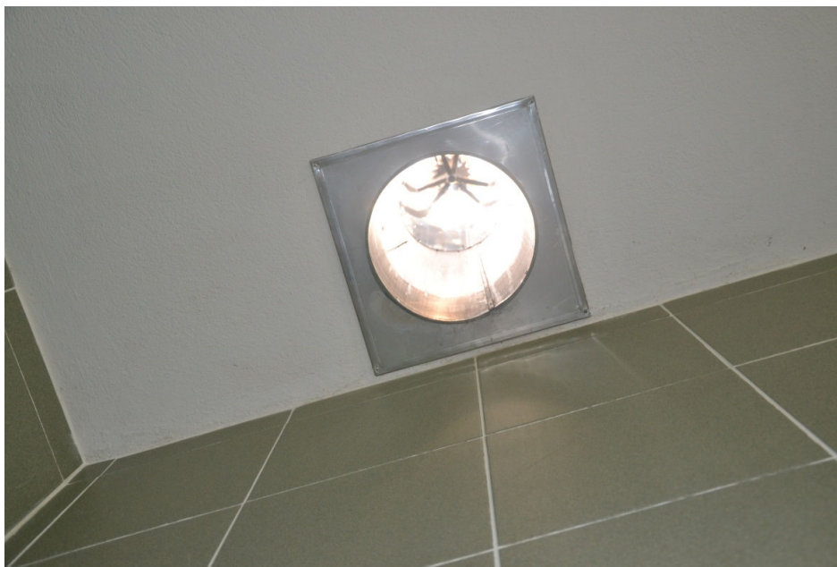
Obrázek 7.32 Odvětrání VDJ Oslavany
