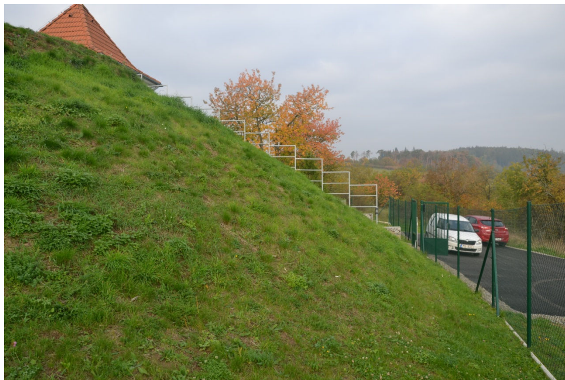
Obrázek 7.24 Zásyp akumulční komory VDJ Oslavany
