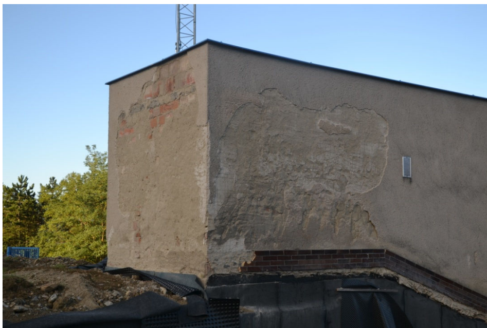
Obrázek 7.19 Nadzemní zděná část VDJ Čebín
