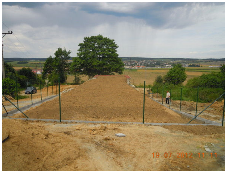
Obrázek 5.3 Trubní VDJ Ostrovačice po zasypání[6]
