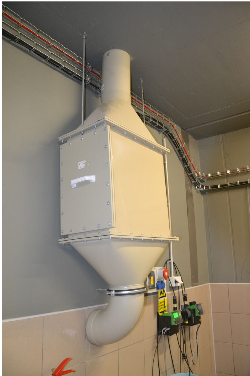
Obrázek 7.6 Filtrační jednotka VDJ Mokrá
