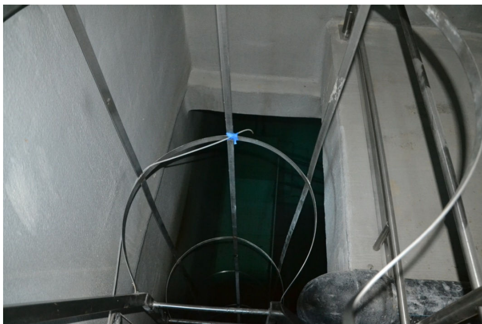
Obrázek 7.21 Nerezový žebřík VDJ Čebín
