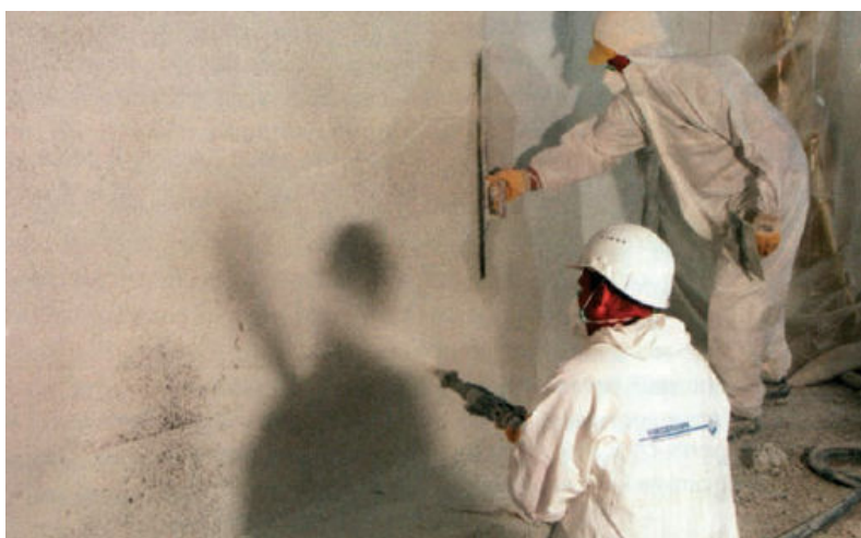
Obrázek 4.20 Nanášení 15 mm silné ochranné vrstvy[12]
