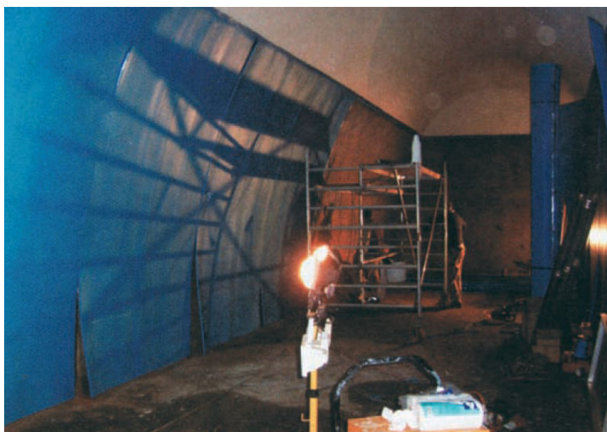
Obrázek 4.14 Akumulační nádrž s montáží horní uzavírací lišty[14]
