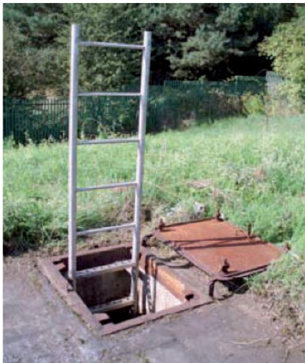
Obrázek 4.1 Přímý vstup do akumulace[20]
