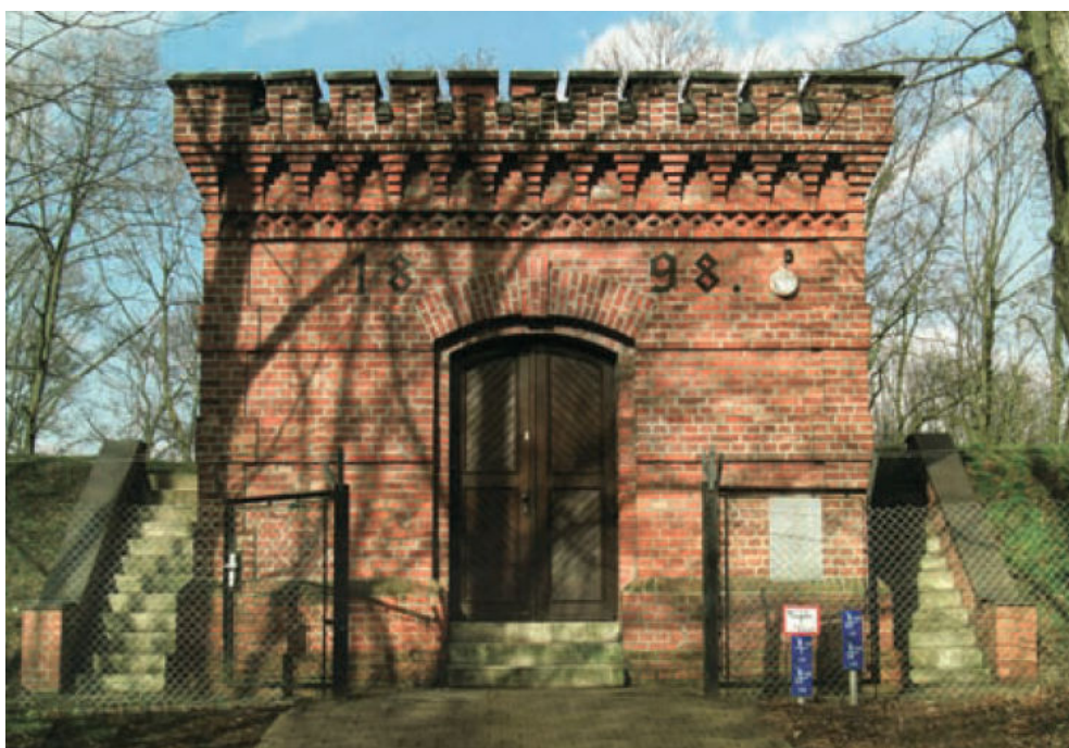
Obrázek 4.11 Vodojem na pitnou vodu v Ascherslebenu[14]
