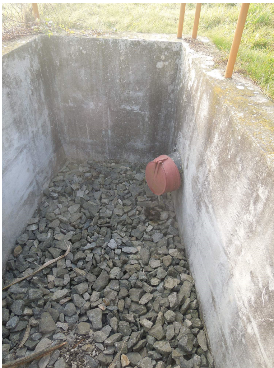
Obrázek 7.13 Žabí klapka na bezpečnostním přelivu
