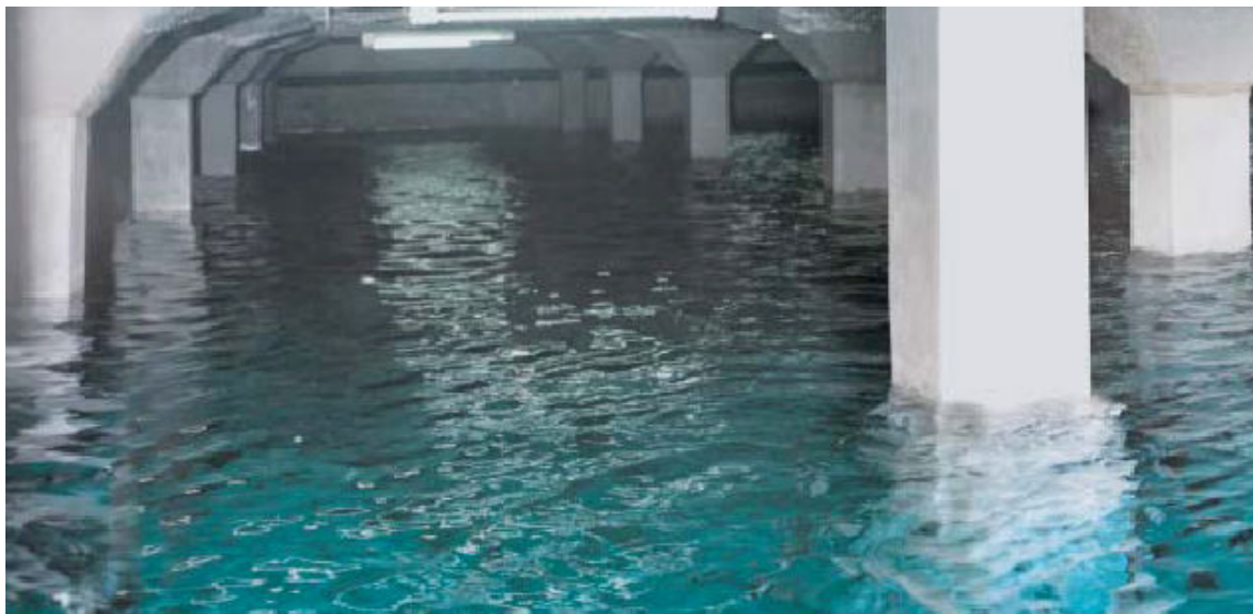
Obrázek 4.18 Akumulační nádrž po aplikaci hydroizolačního materiálu VANDEX[28]
