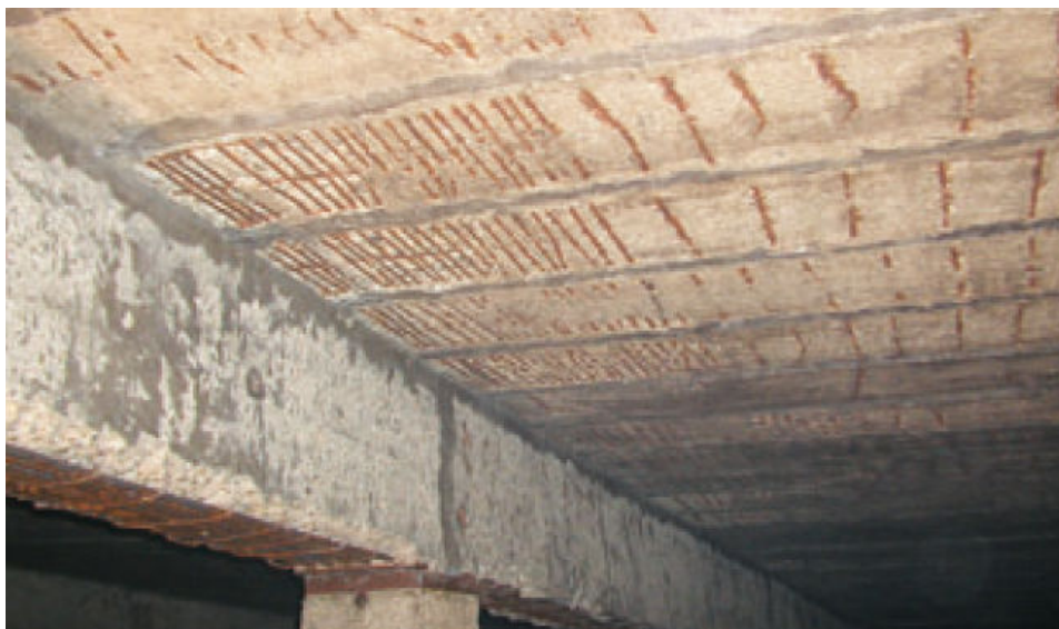
Obrázek 4.17 Příklad sanovaných povrchů akumulční nádrže po otrýskání[11]
