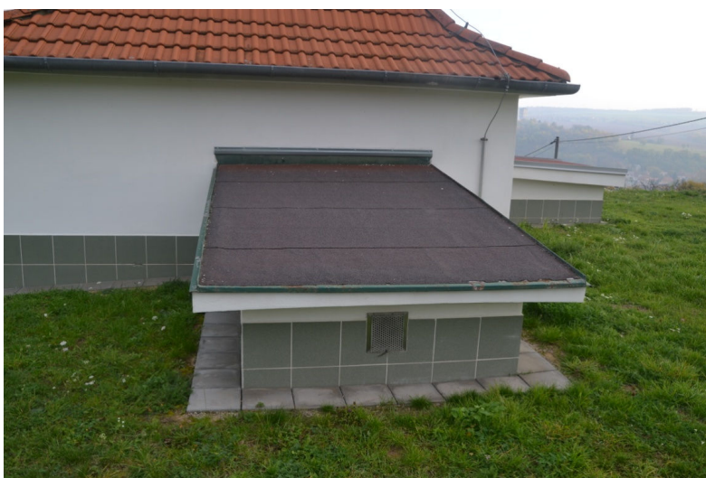
Obrázek 7.30 Vyvýšený objekt tvořící vstup do akumulace a odvětrání akumulace
