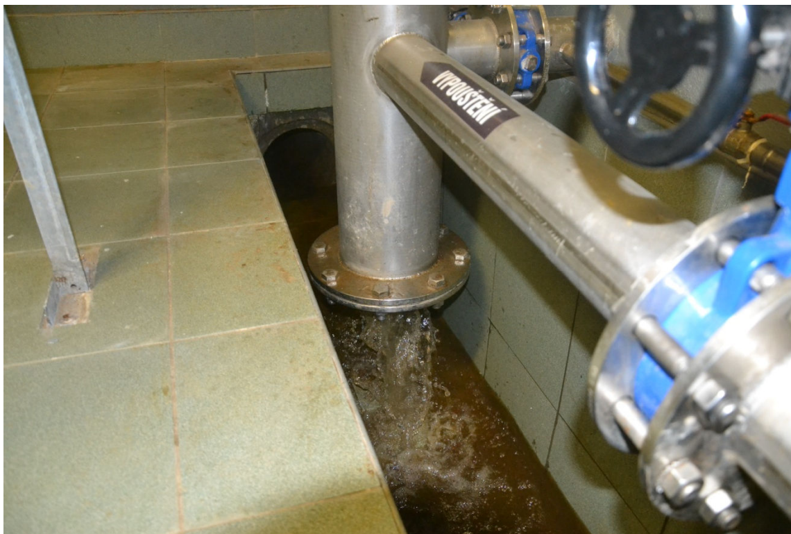
Obrázek 7.28 Vypouštěcí potrubí
