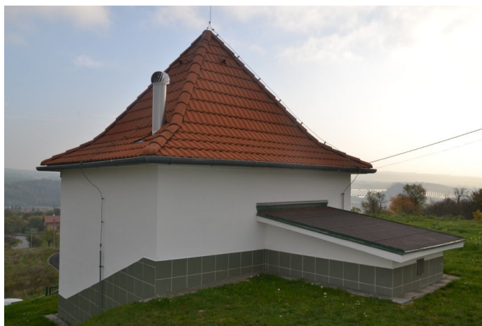
Obrázek 7.29 Nadzemní část VDJ Oslavany
