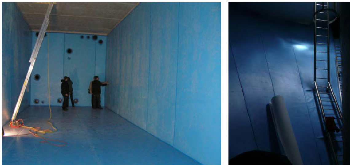
Obrázek 4.10 Návodní líc vodojemů-mechanicky kotvené desky a fólie[15]
