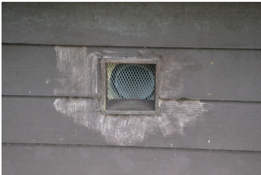
Obrázek 7.16 Odvětrání akumulční nádrže VDJ Ochoz u Brna
