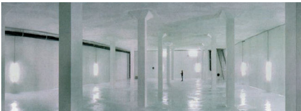
Obrázek 4.21 Výsledný povrch akumulace po sanaci[12]
