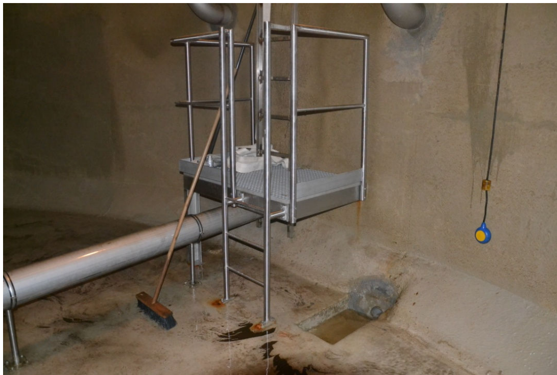
Obrázek 7.26 Nerezová plošina VDJ Oslavany
