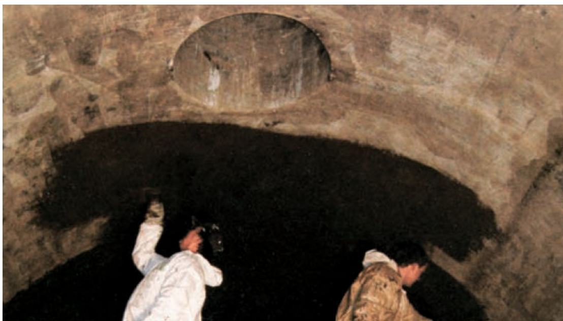
Obrázek 4.13 Sanovaný strop nádrže[14]
