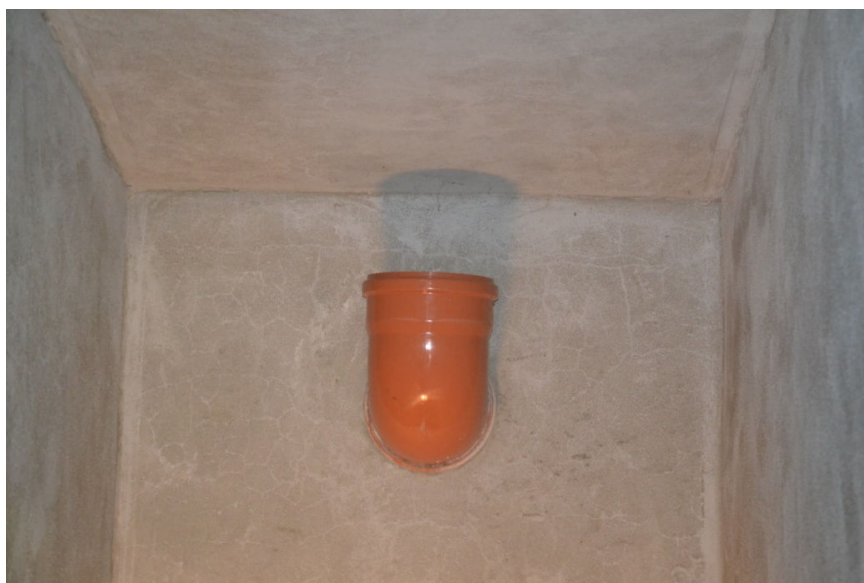
Obrázek 7.31 Odvětrání VDJ Oslavany
