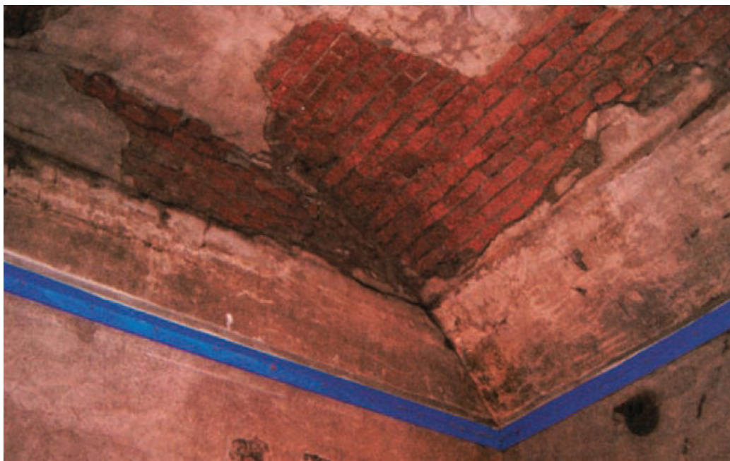
Obrázek 4.12 Klenutý strop po vyčištění vysokotlakou vodou[14]
