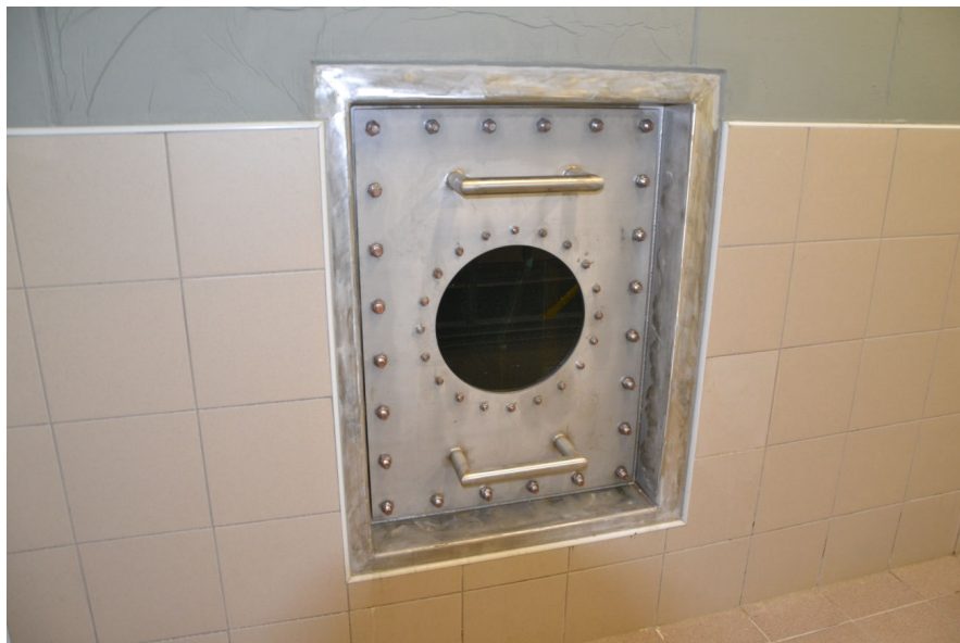
Obrázek 7.4 Ponořený vstup do akumulční komory VDJ Mokrá
