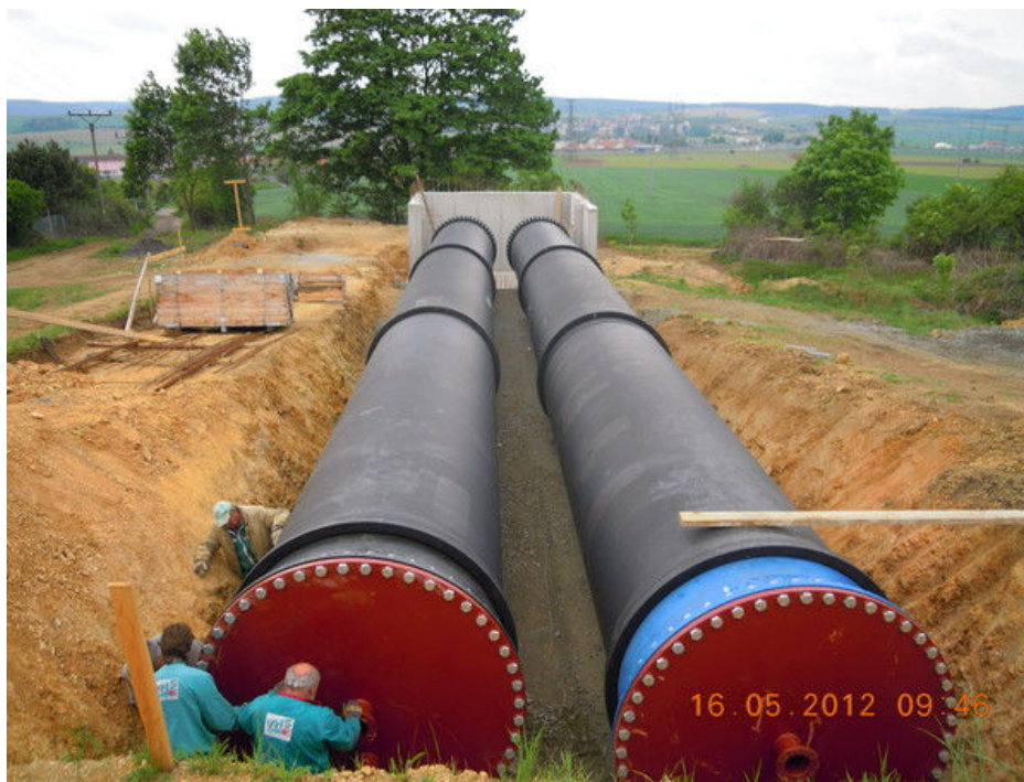
Obrázek 5.2 Trubní VDJ Ostrovačice [8]
