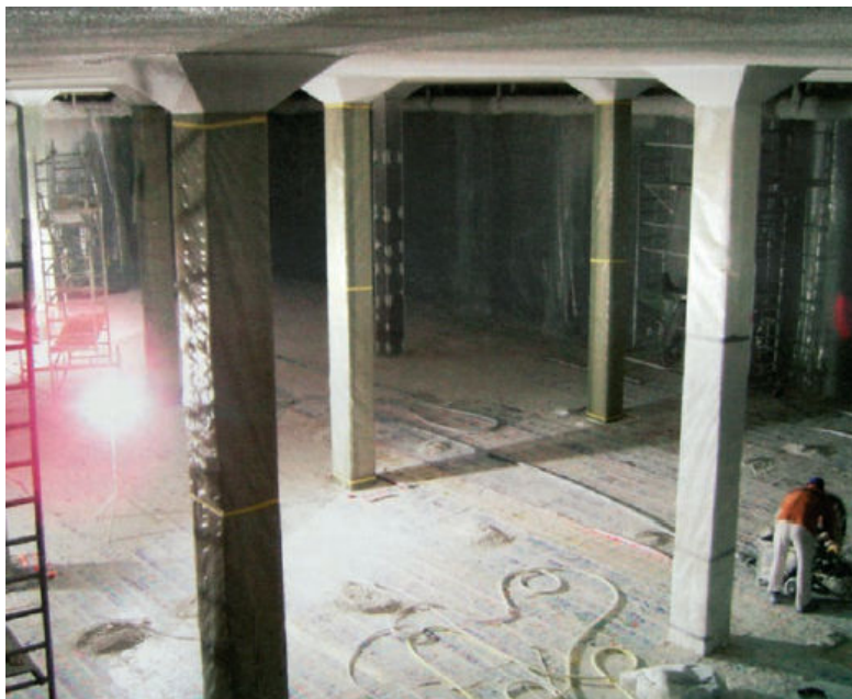
Obrázek 4.19 Zpracování stropu na 6m vysokých mobilních lešeniích[12]
