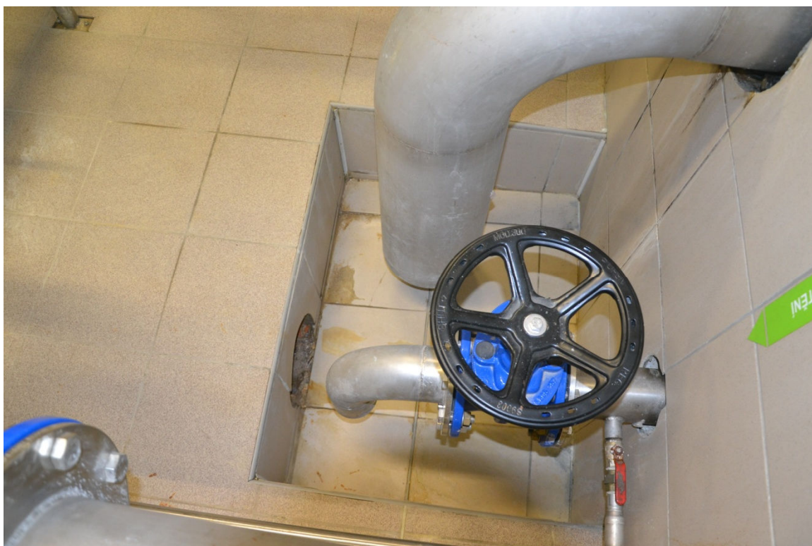
Obrázek 7.9 Vyústění výpustného a přelivného potrubí
