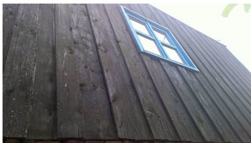
Obr. 2. Rodinný dom architekta Milučkého (foto: Peter Kasman)
