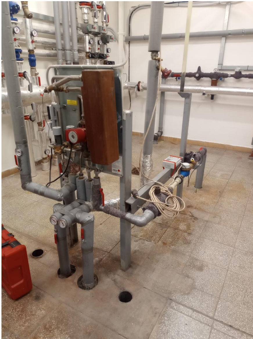
Obrázek 19 zabudování snímače průtoku – měřený objekt
