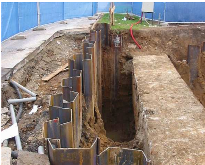
Obrázek 2 - 5 - Štětovnicová stěna ze štětovnic typu IIn[12]
