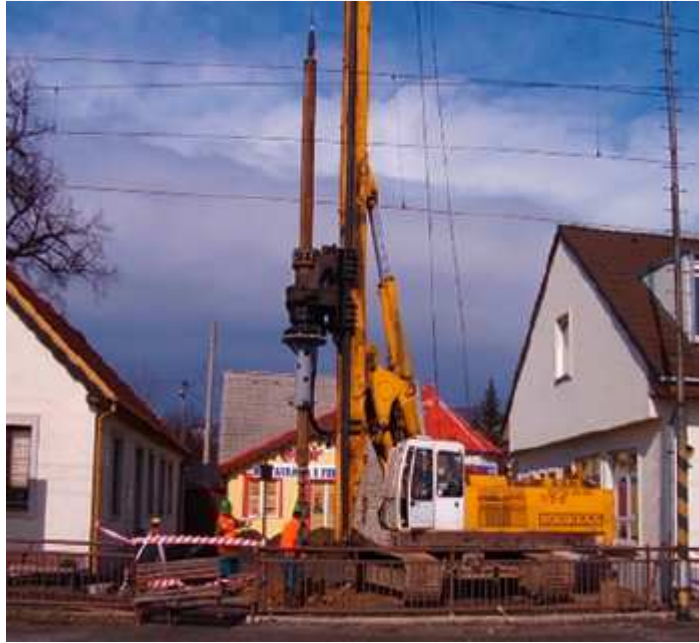
Obrázek 5 – 2 - Mechanizace pro provádění vrtů vrtaných pilot[12]
