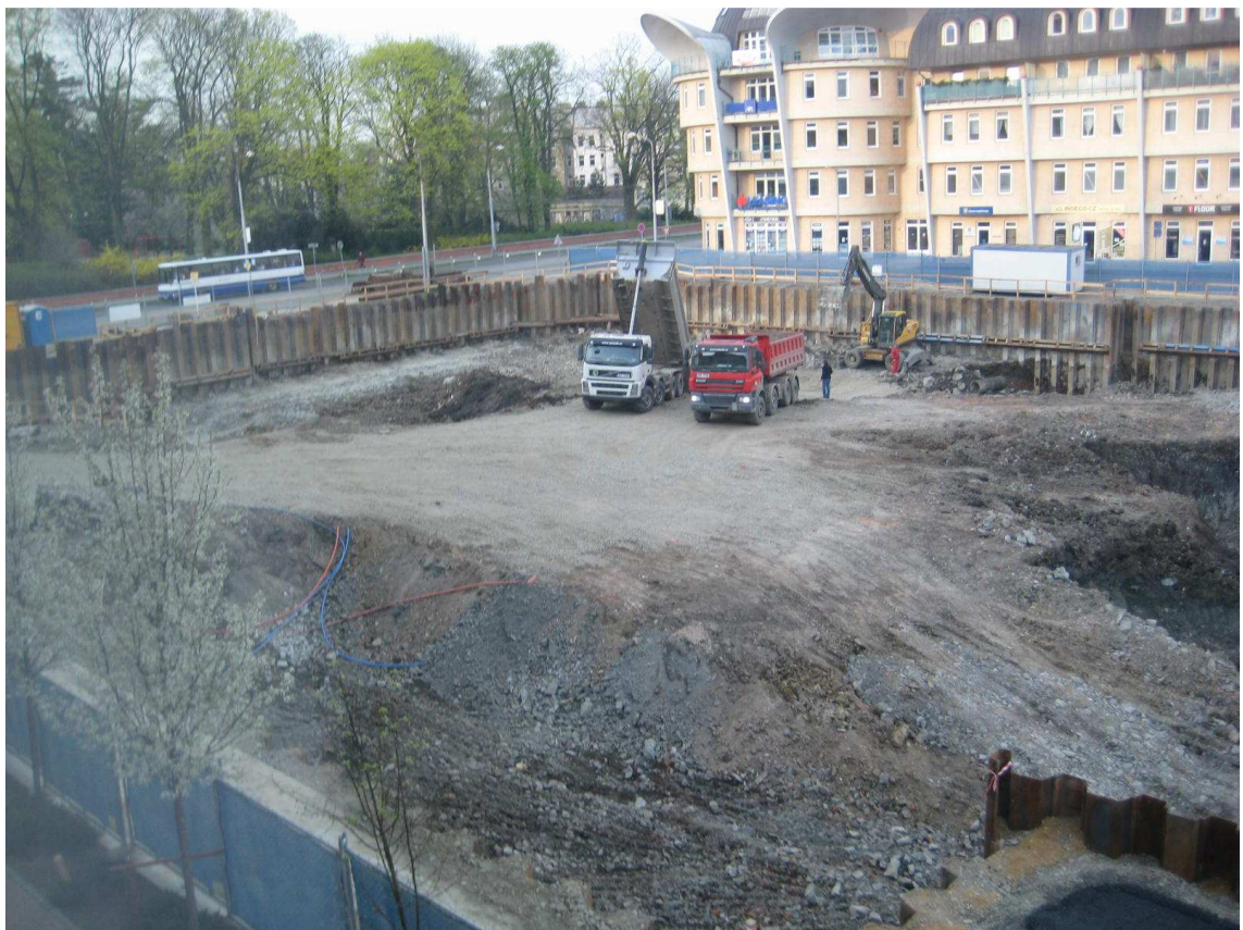
Obrázek 4 – 5 - Postup hloubení stavební jámy 1
