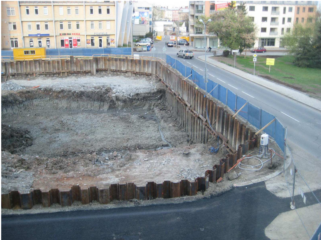
Obrázek 4 – 6 - Postup hloubení stavební jámy 2
