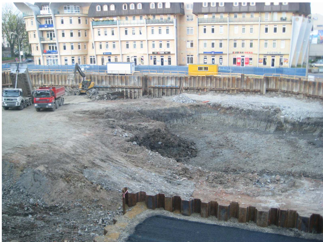
Obrázek 4 – 7 - Postup hloubení stavební jámy 3
