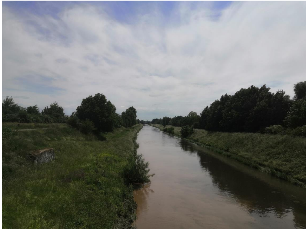
Obrázek 8: Řeka Svratka, pohled ve směru toku z Přízřenického mostu [16]
