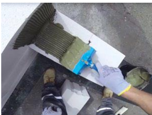
Obrázek G.7.1.4-2 – Nanášení malty zednickou lžící Porfix, svislá spára (zdroj [9])
