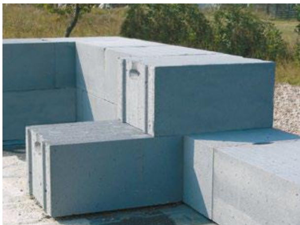
Obrázek G.7.3-1 – Provázání rohu, správné řešení (zdroj [9])
