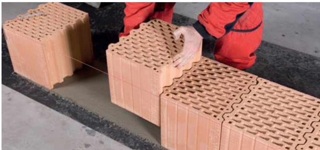
Obrázek D.7.1.3 – Zdění první řady (zdroj [4])
