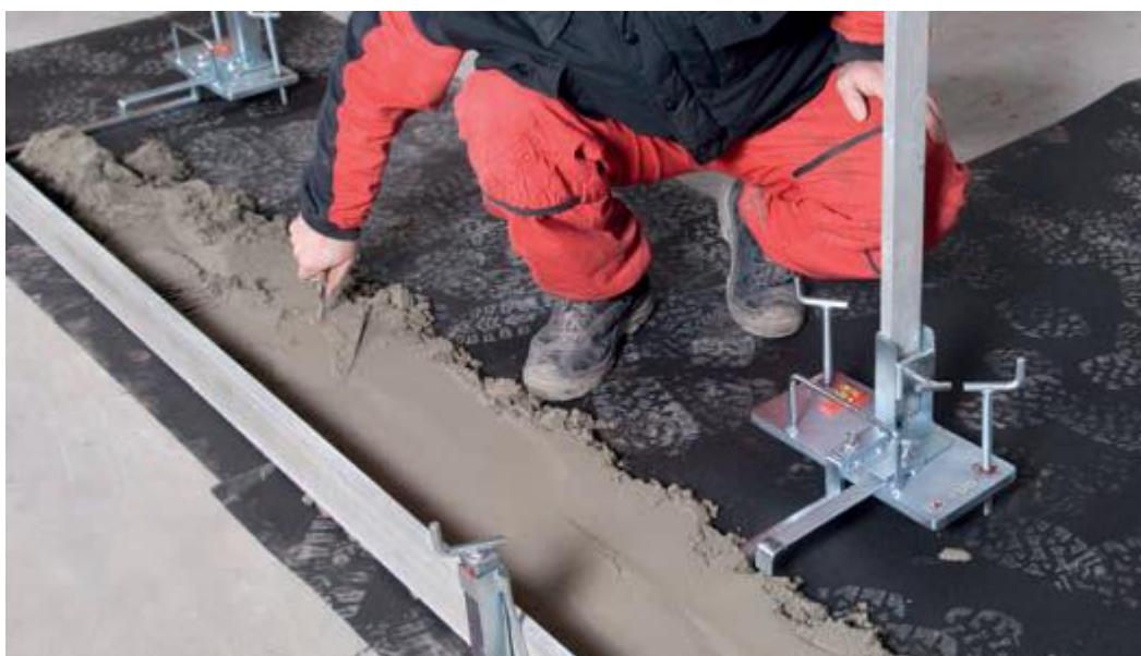
Obrázek D.7.1.2-2 – Práce s vyrovnávací soupravou (zdroj [4])
