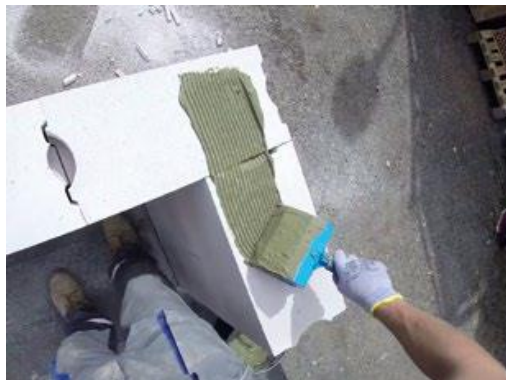
Obrázek G.7.1.4-1 – Nanášení malty zednickou lžící Porfix (zdroj [9])
