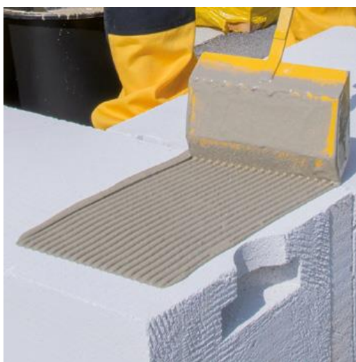
Obrázek F.7.1.4-1 – Nanášení malty zednickou lžicí Ytong (zdroj [7])
