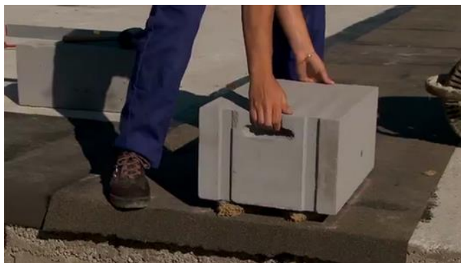
Obrázek G.7.1.2 – Založení rohu (zdroj [10])
