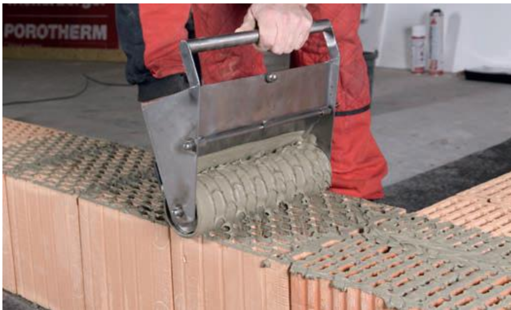
Obrázek D.7.1.4 – Nanášení malty válcem (zdroj [4])
