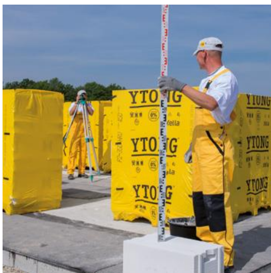
Obrázek F.7.1.2-2 – Kontrola výšky založení (zdroj [7])
