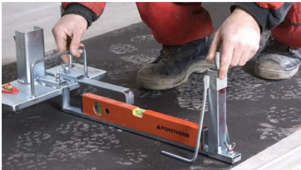
Obrázek D.7.1.2-1 – Vyrovňovací souprava vyvážení (zdroj [4])
