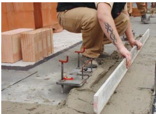
Obrázek E.7.1.2-2 – Práce s vyrovnávací soupravou (zdroj [5])
