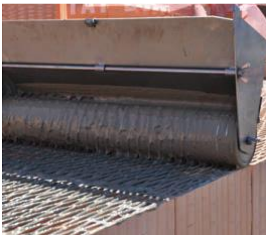
Obrázek E.7.1.4 – Nanášení malty válcem (zdroj [5])
