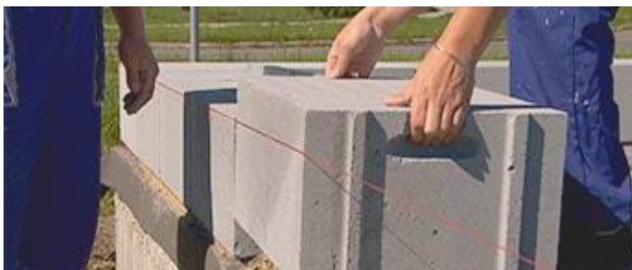
Obrázek G.7.1.3 – Zdění první řady (zdroj [11])
