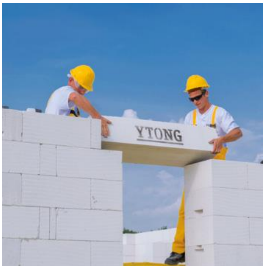
Obrázek F.7.1.5 – Překlad Ytong NOP (zdroj [7])
