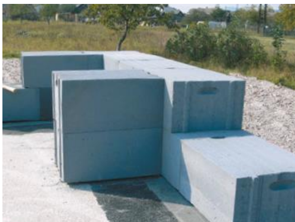
Obrázek G.7.3-2 – Provázání rohu, špatné řešení (zdroj [9])
