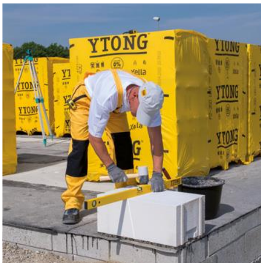
Obrázek F.7.1.2-1 – Založení rohu (zdroj [7])
