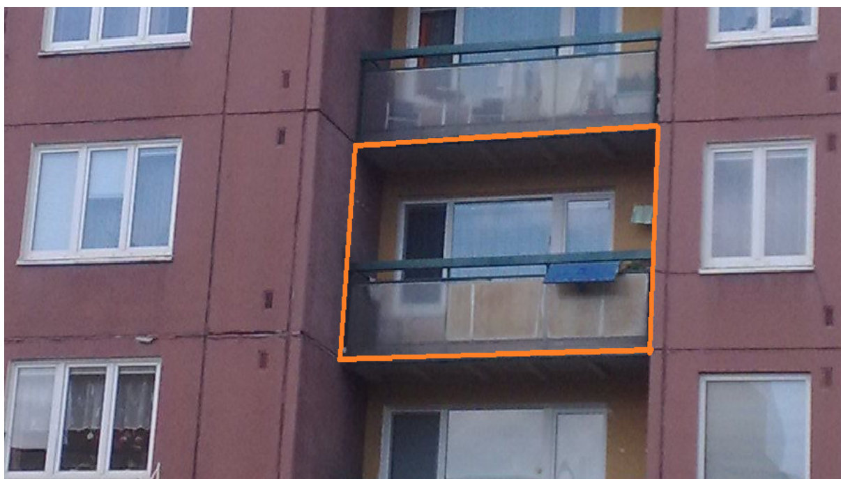
Obr. 5.3: Detailní pohled na lodžii
