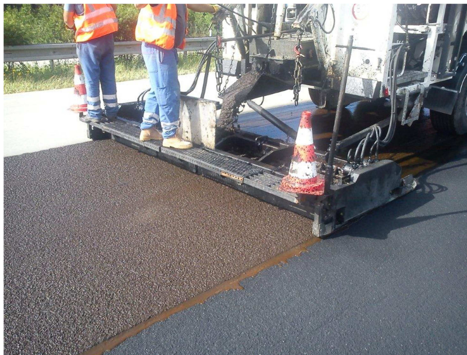
Obrázek 7 Kladecí rám při pokládce čerstvé směsi [19]
