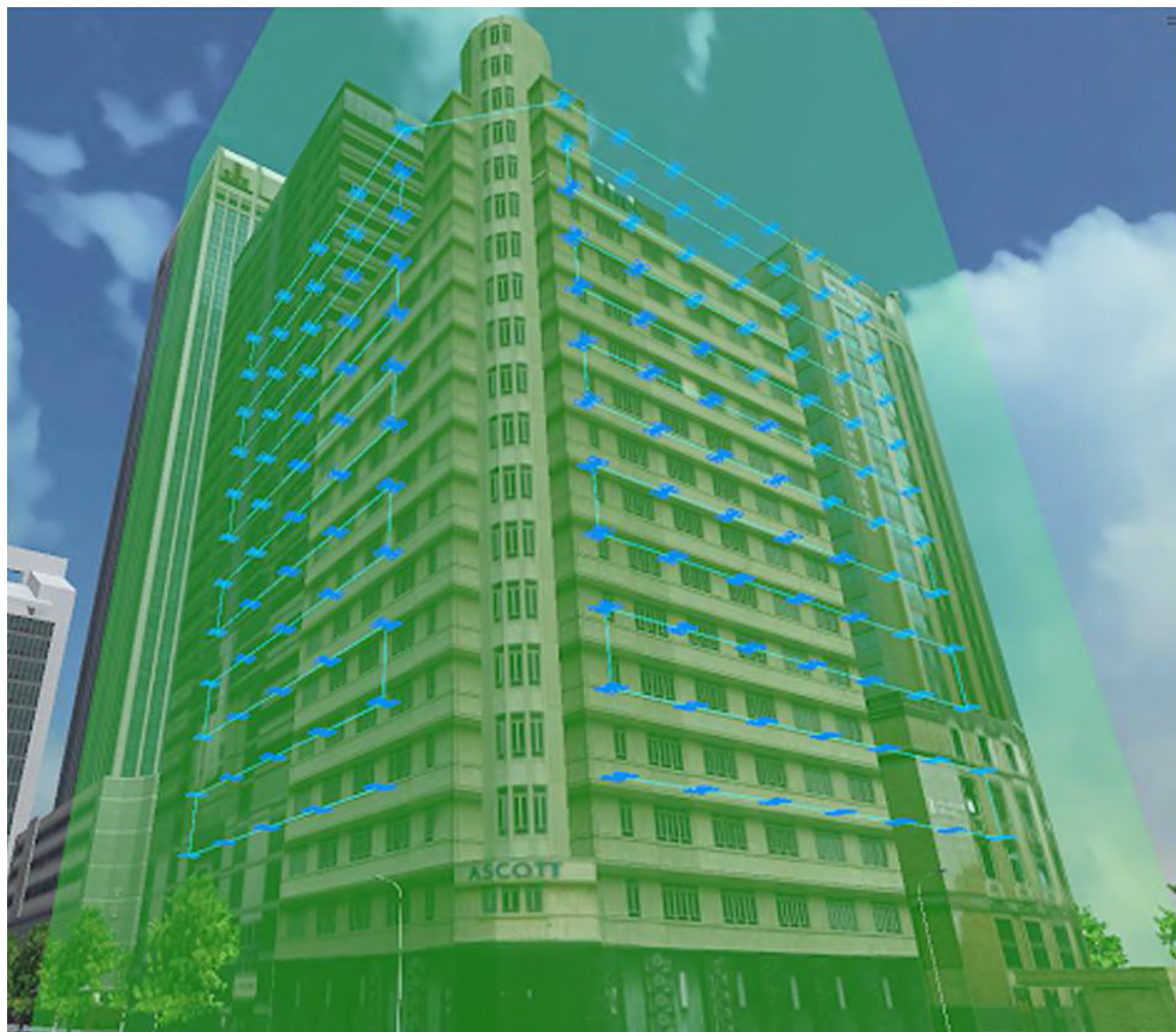
Obrázek 2.4: Označení budovy k inspekci s trajektorií průletu dronu [16].
