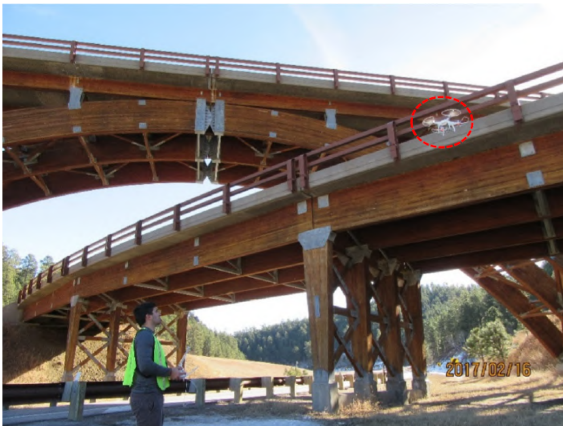
Obrázek 2.2: Snímek z kontroly mostu v rámci studie [13].
