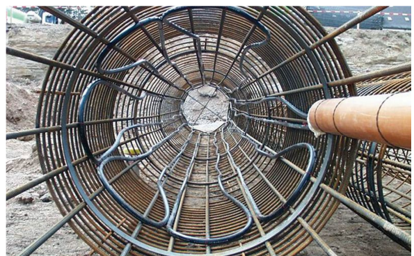
Obr. 12 Vystrojení energetických pilot [19]
