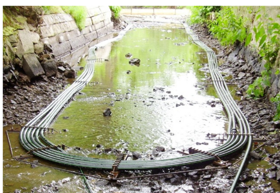
Obr. 16 Tepelné čerpadlo voda/voda – kolektory umístěny v potoce nebo rybníku [24]
