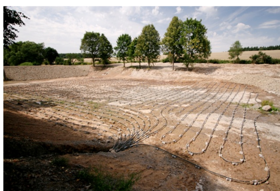
Obr. 16 Tepelné čerpadlo voda/voda – kolektory umístěny v potoce nebo rybníku [24]
