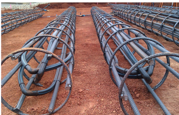
Obr. 12 Vystrojení energetických pilot [19]
