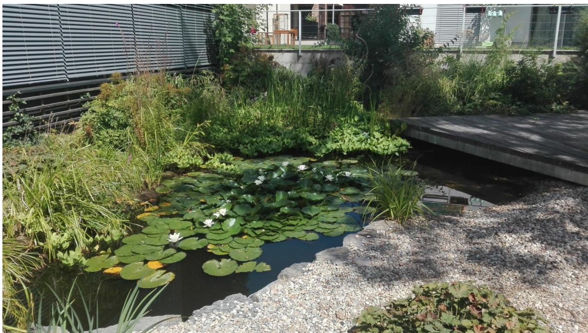
Obrázek 5.3 Přírodní kořenová čistírna šedých vod v Otevřené Zahradě [Velikovská]
