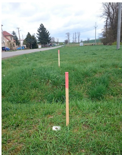
Obr. 6.4: Stabilizace hranice obvodu pozemkové úpravy
