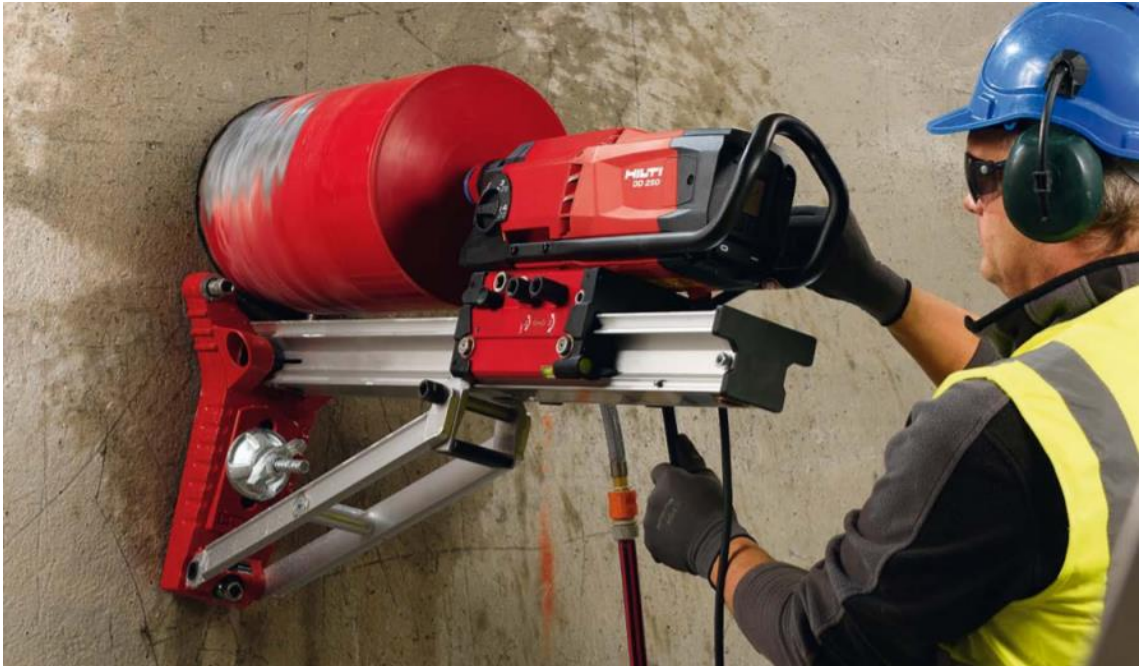
Obrázek 1 Provádění jádrového výtvtu [19]
