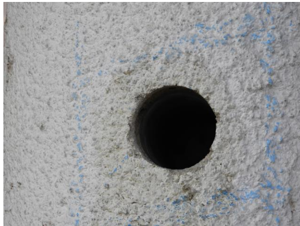
Obrázek 18 Otvor po vyvrtání jádrového vývrtu
