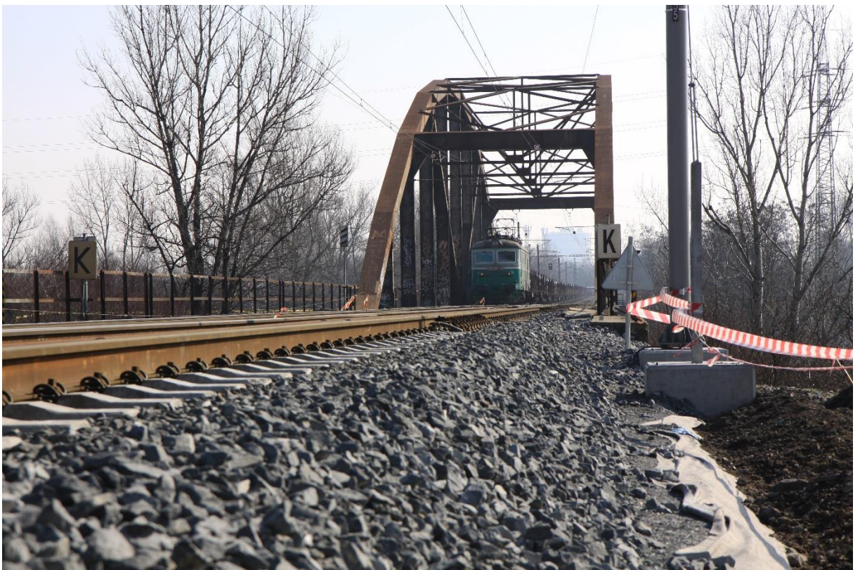
Obrázek 5 Ocelový most bez průběžného kolejového lože
