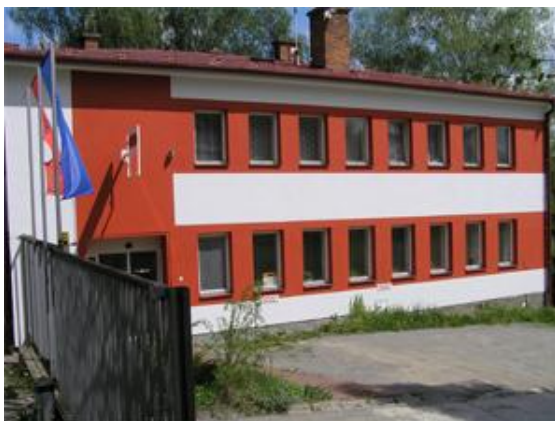
Obr.1. Budova firmy Steko Krby
