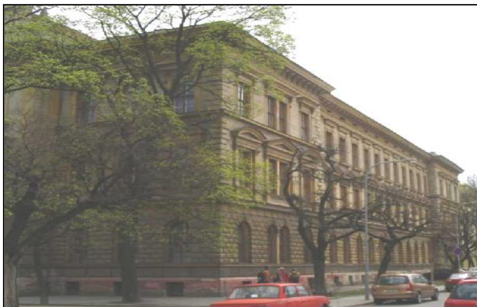
Obr. 5 - Pohled na západní křídlo z křižovatky ulic Mlýnská – Cyrilská [15]
