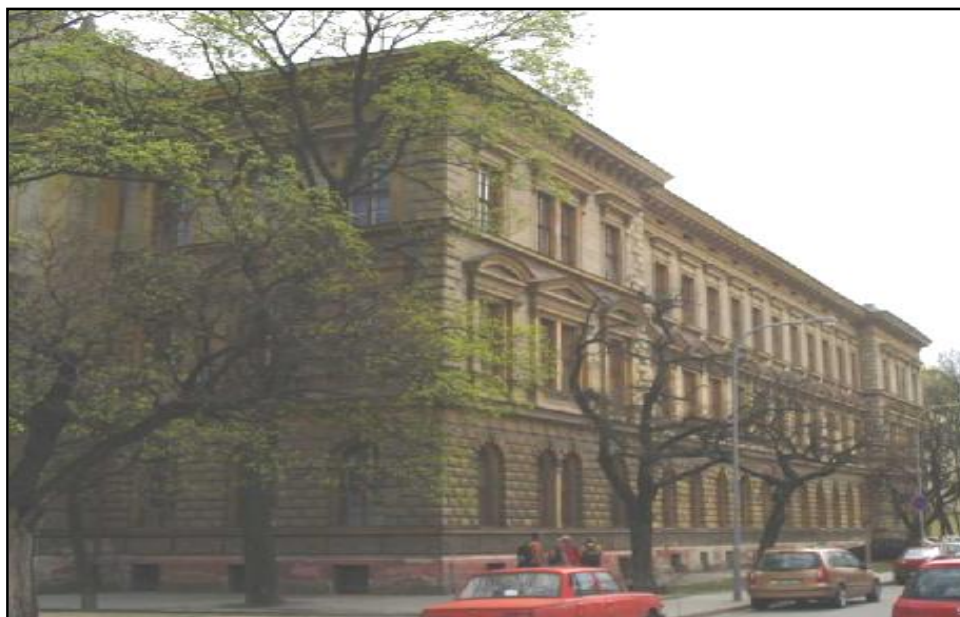
Obr. 36 - Pohled na západní křídlo z křižovatky ulic Mlýnská – Cyrilská [15]
