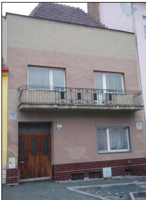
Obr. 25 - Objekt 2. Veleslavínova 12/č.p. 1199
