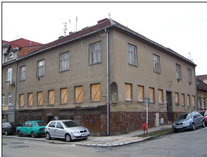
Obr. 23 - Objekt 1. Veleslavínova 1/č.p. 245
