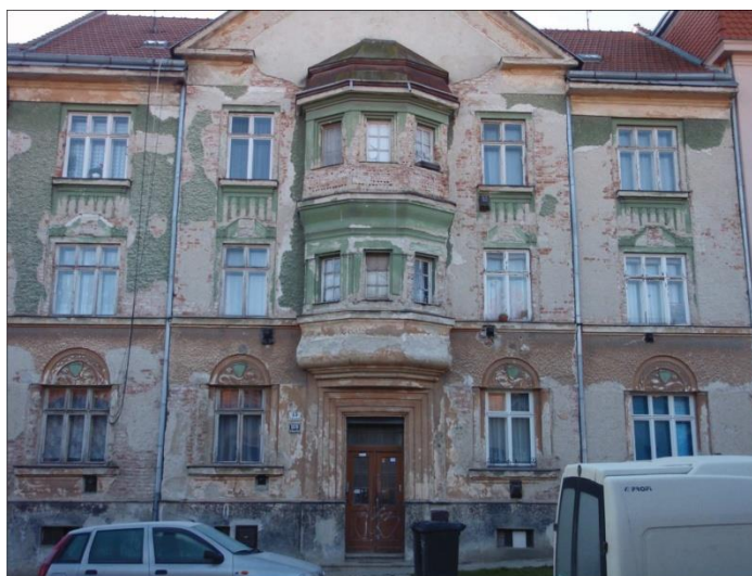
Obr. 27 - Čelní fasáda sledovaného domu na ulici Dobrovského v Brně
