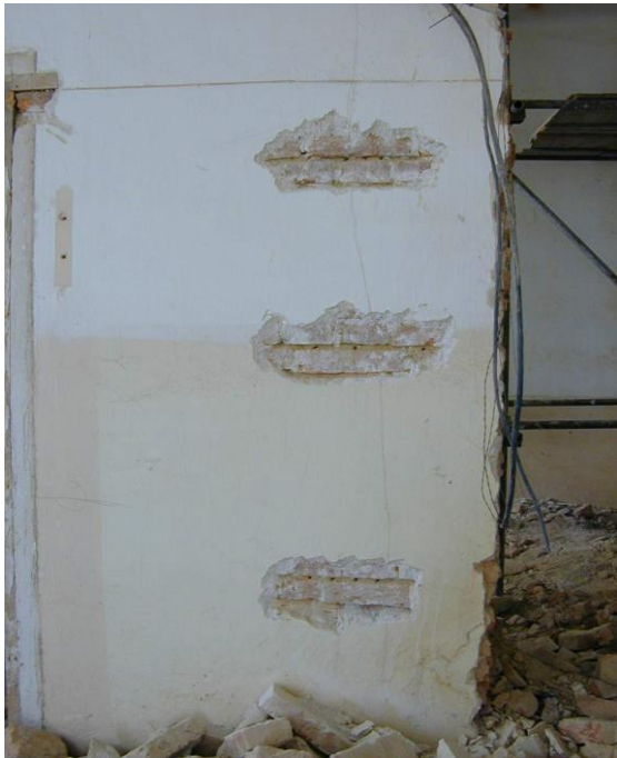
Obr. 18 - Zkušební místa na pilířích
