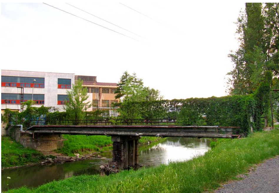
Obr. 40: Železobetonový most v ulici Dačického [18]
