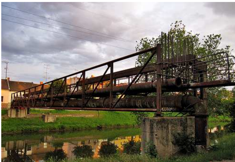
Obr. 39: Ocelová lávka pro trubní vedení v nadjezí [18]
