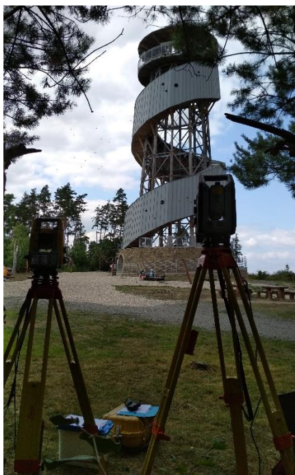
Obrázek 27 – Postavení totálních stanic vzhledem k zájmovému objektu [doc. Bureš]
