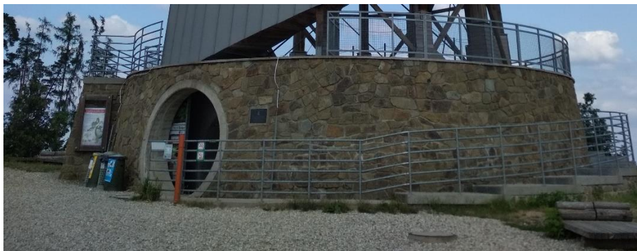
Obrázek 8 – Detail na kamenem obložený podstavec rozhledny [autor]
