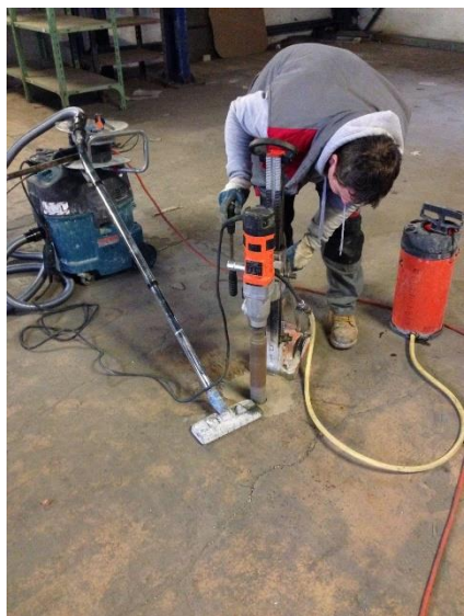
Obrázek 26 Ilustrační obrázek provádění jádrových odvrtů. Zdroj: Autor
