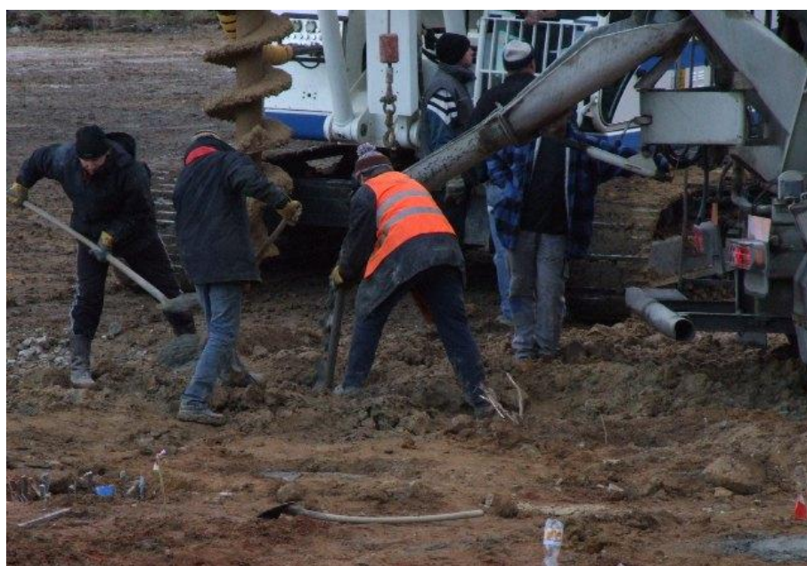
Obr. Betonáž piloty
