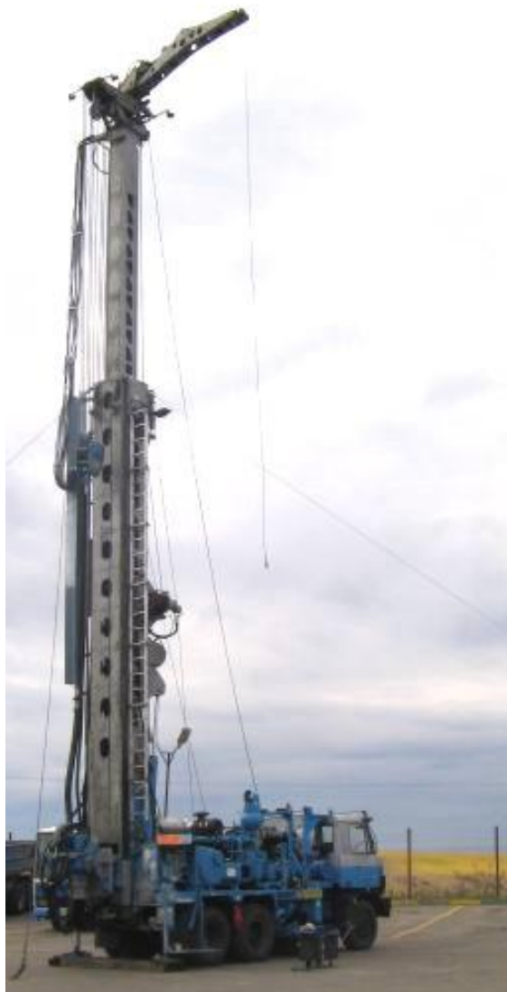
Obr. Vrtná souprava - vysunutá věž
