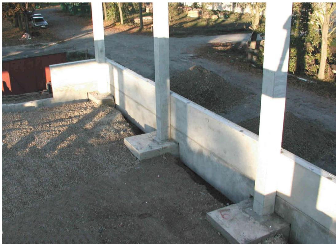
Obr. Uložení základových prahů
