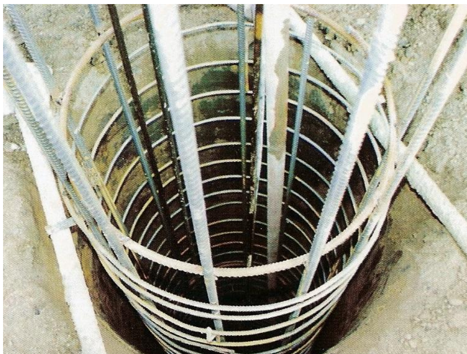
Obr. Umístění armokoše do piloty
