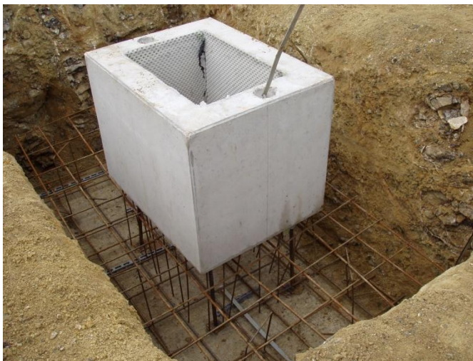
Obr. Uložení prefabrikovaného kalichu
