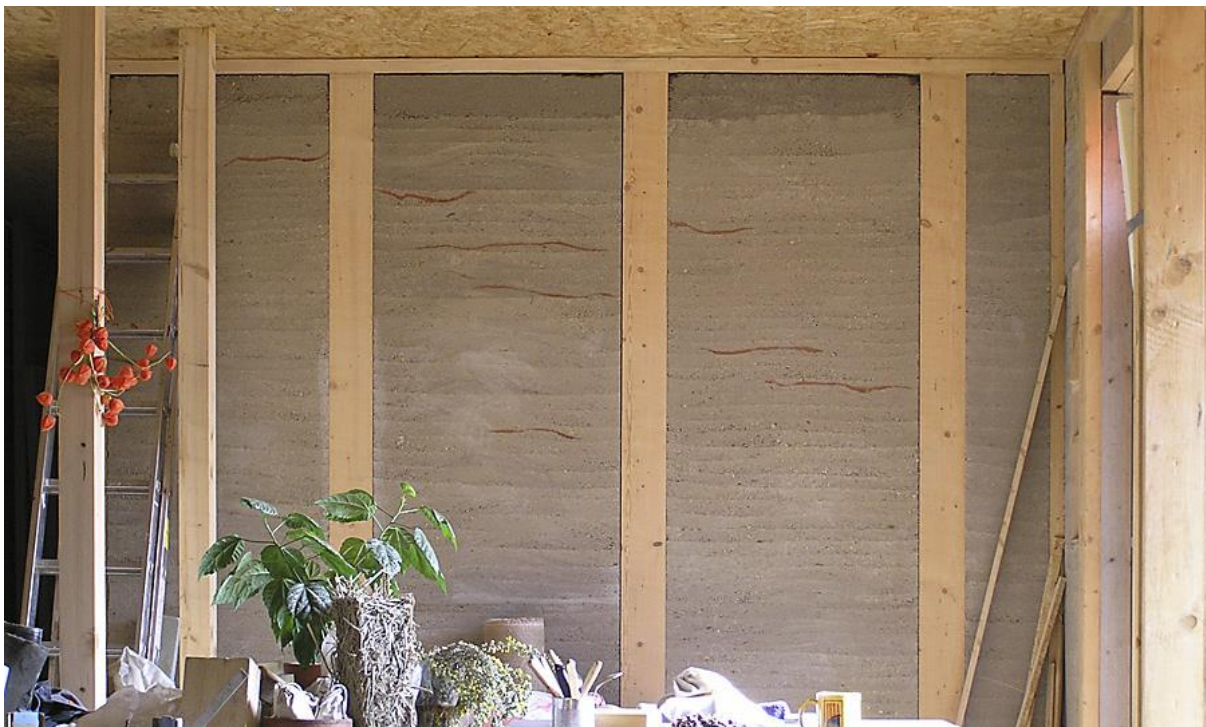
Obrázek 16: Pohledová stěna z dusané hlíny v interiéru rodinného domu [24]
