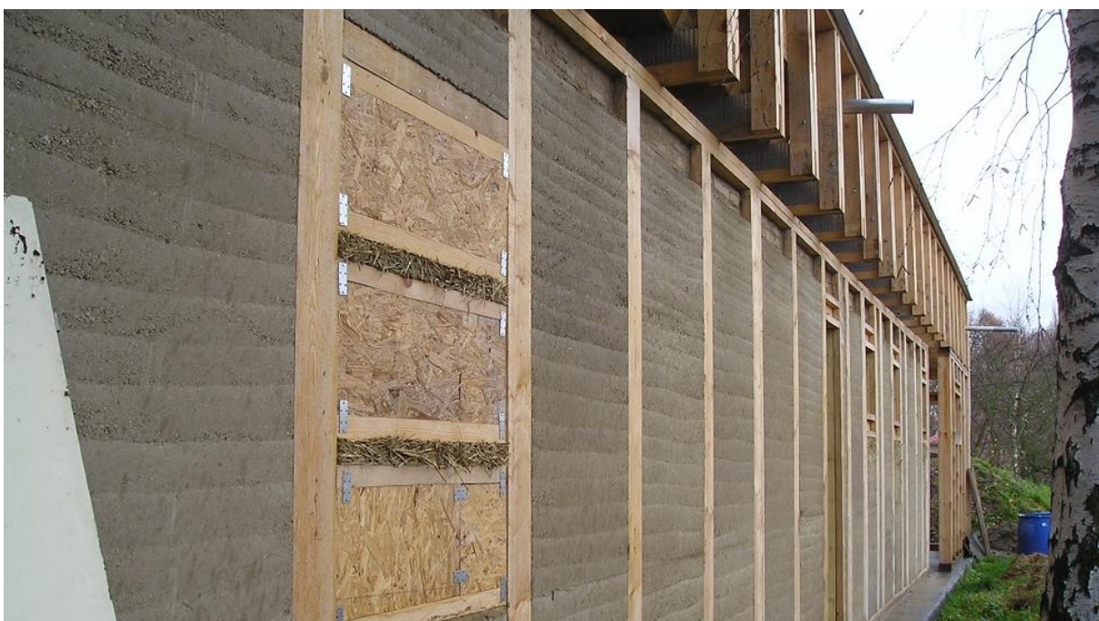
Obrázek 15: Pohled na nosnou dřevěnou stěnu vyplněnou dusanou hlínou před instalací dřevěného obkladu [24]
