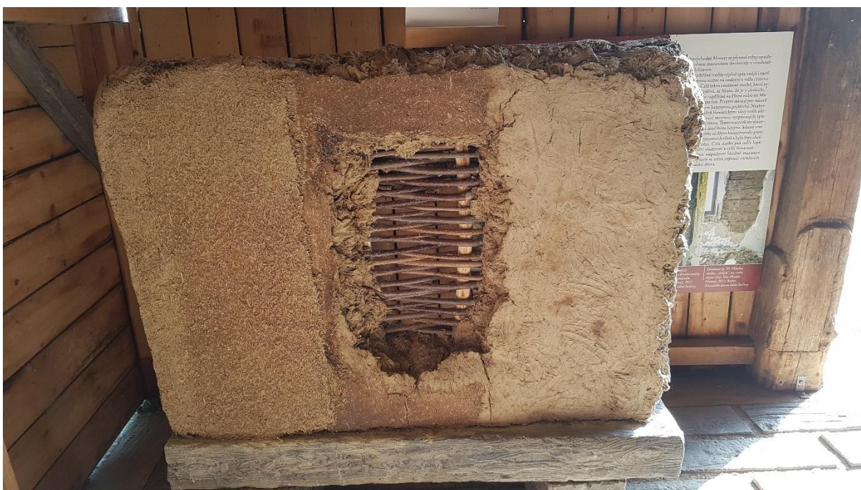
Obrázek 5: Dřevěný výplet obalený hliněnou směsí [foto autor]
