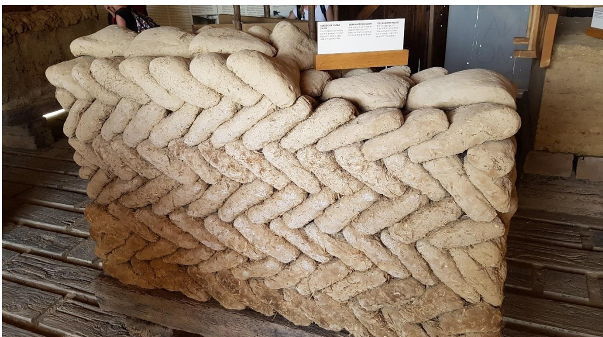
Obrázek 3: Zdivo z trojúhelníkových válek poskládané do klasovité vazby [foto autor]
