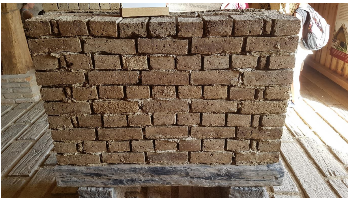
Obrázek 1: Zdivo z nepálených cihel spojených hliněnou maltou [foto autor]
