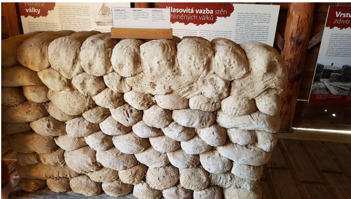
Obrázek 2: Zdivo z hliněných válek [foto autor]
