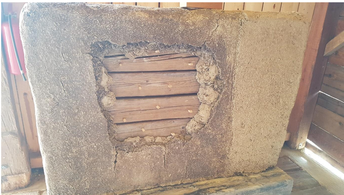
Obrázek 6: Trámová stěna obalená hliněnou směsí [foto autor]
