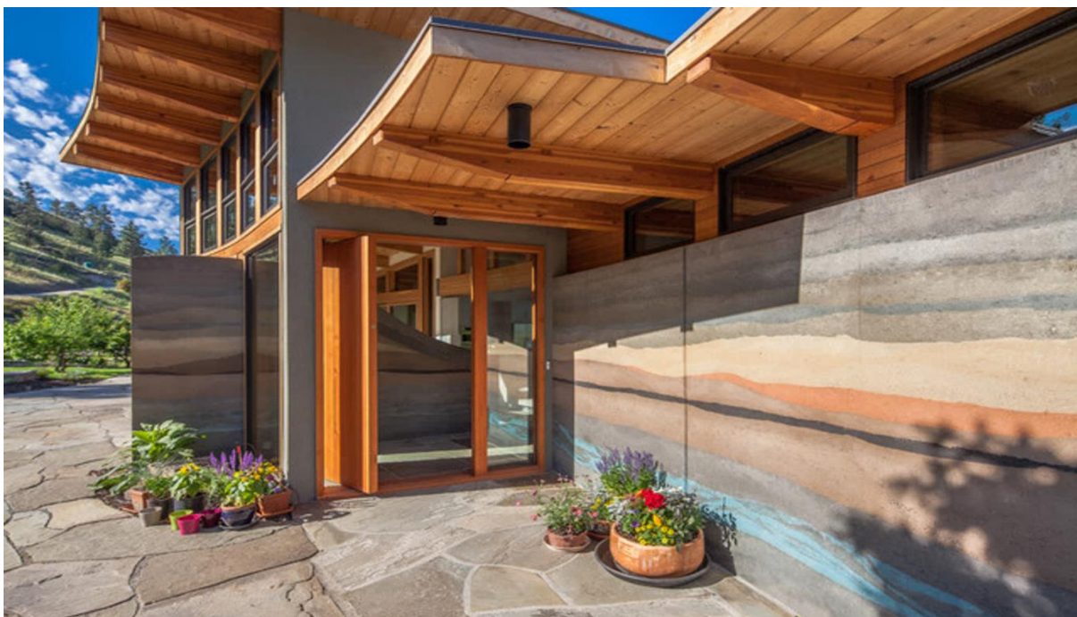
Obrázek 12: Příklad probarvené hliněné dusané stěny [32]
