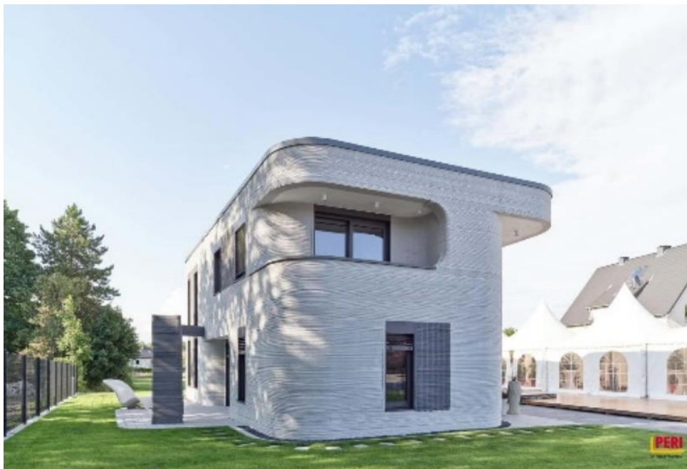
Obr. 46) První německý 3D tištěný obytný dům ve spolupráci s firmou PERI [43]
