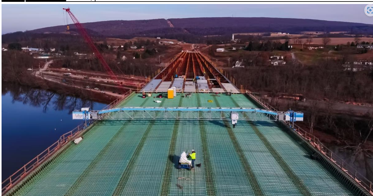
Obr. 55) Nasazení PR TyBOT pro automatizaci vázání výztuže při výstavbě mostu přes řeku Susquehanna [61]
