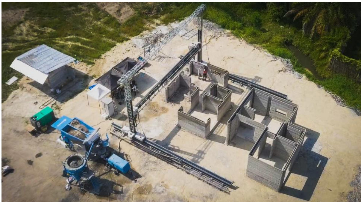
Obr. 50) Nová generace stavební 3D tiskárny BOD3 včetně přidruženého systému dopravy materiálu [53]
