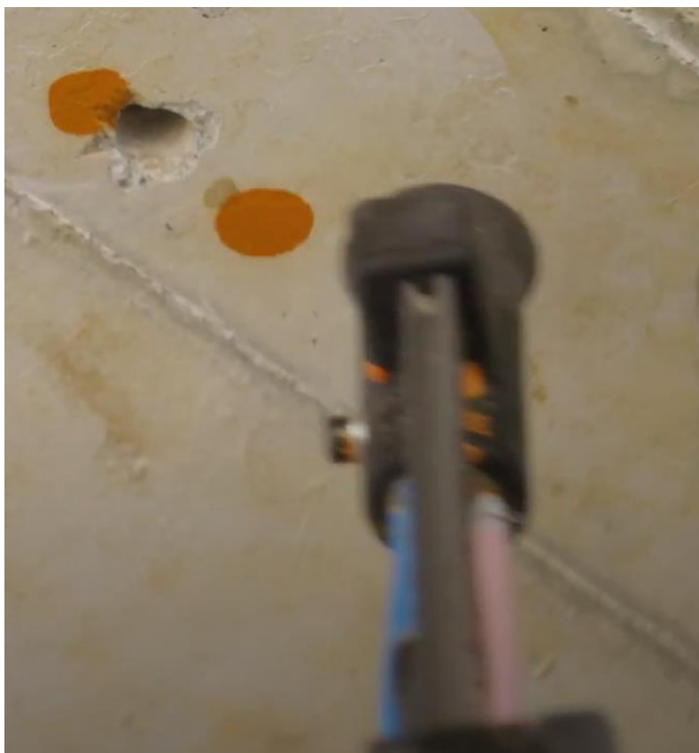
Obr. 63) Vrt provedený PR JAIBOT a následné označení jeho pozice pomocí značkovací jednotky robotu [74]
