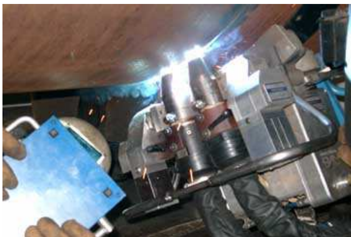
Obr. 2.20 Svařování potrubního vedení 11
