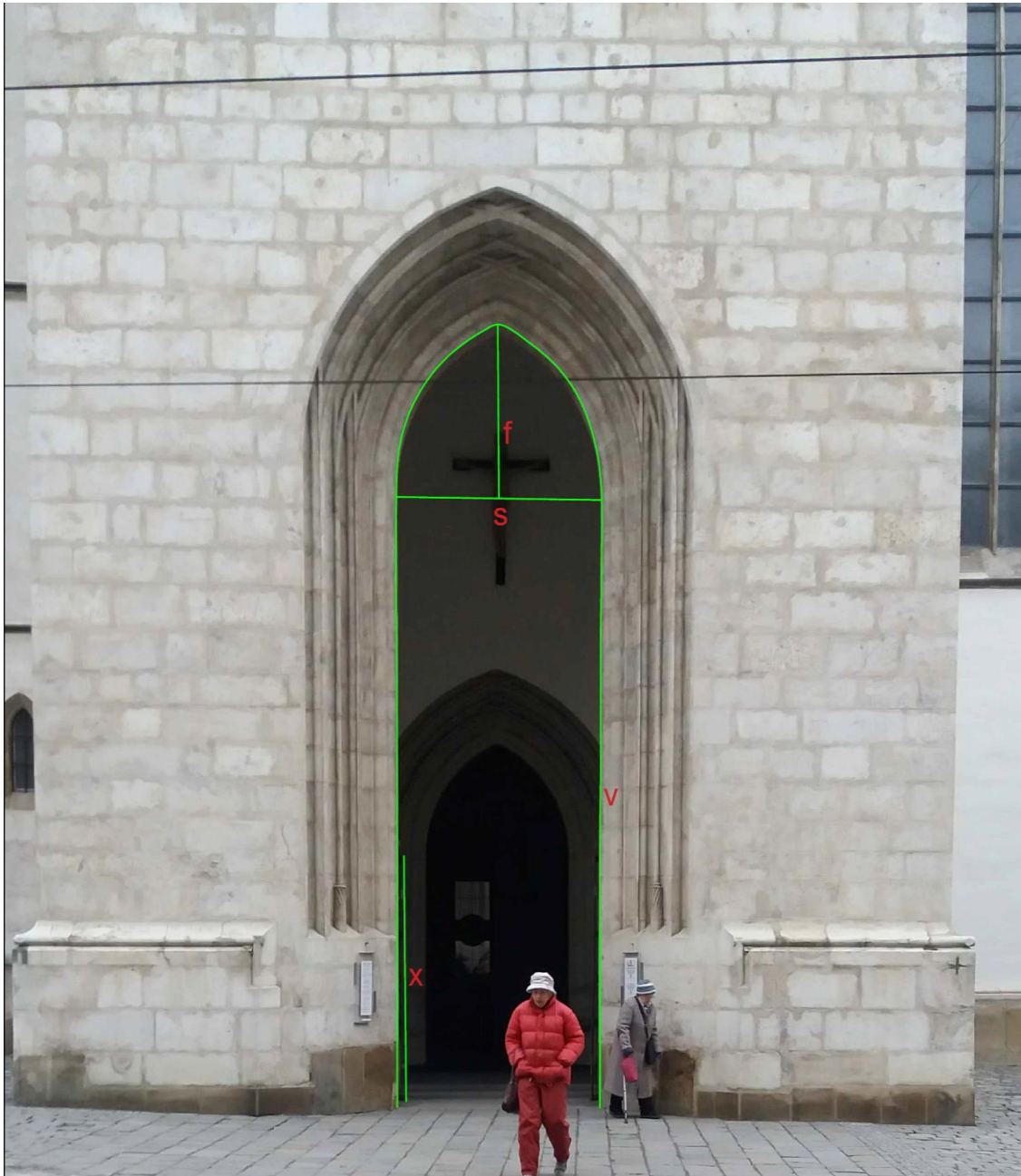
Obr. 5.4 Vchodová klenba vnitřní
