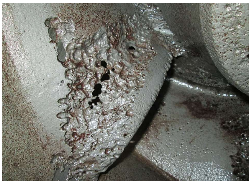
Obrázek 4.1 Poškozený povrch lopatky kavitací [17]
