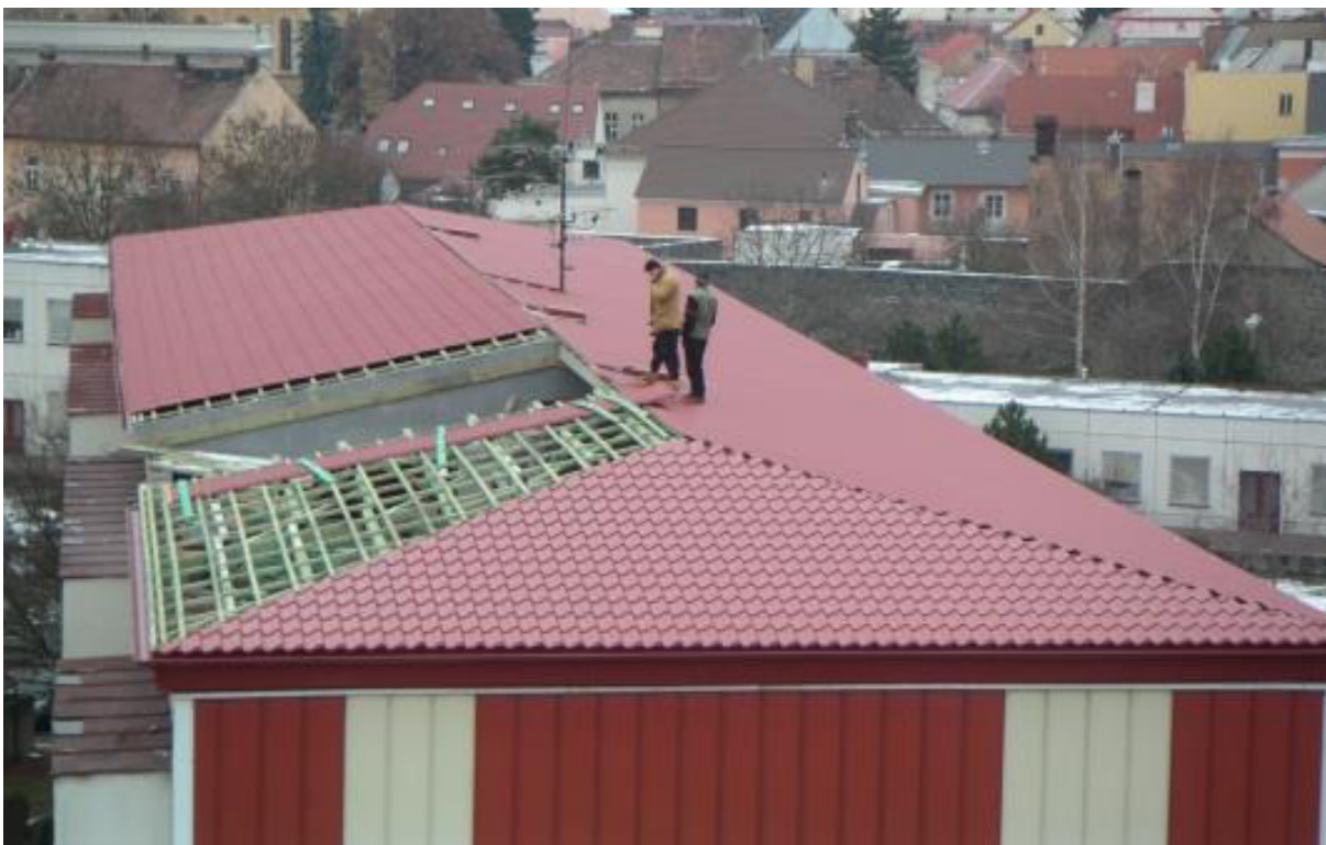
Oprava střechy v roce 2005
