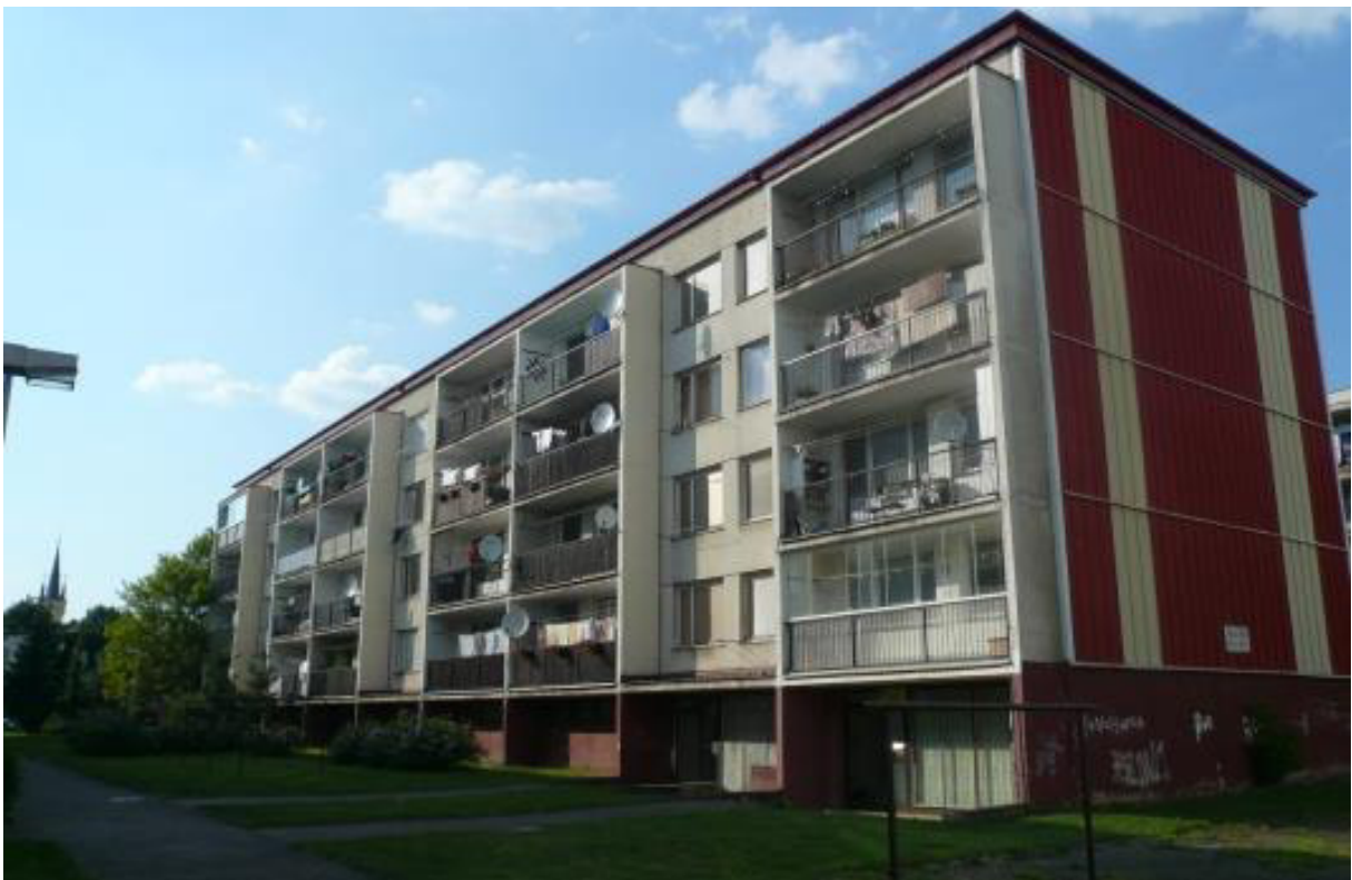
Zadní strana bytového domu
