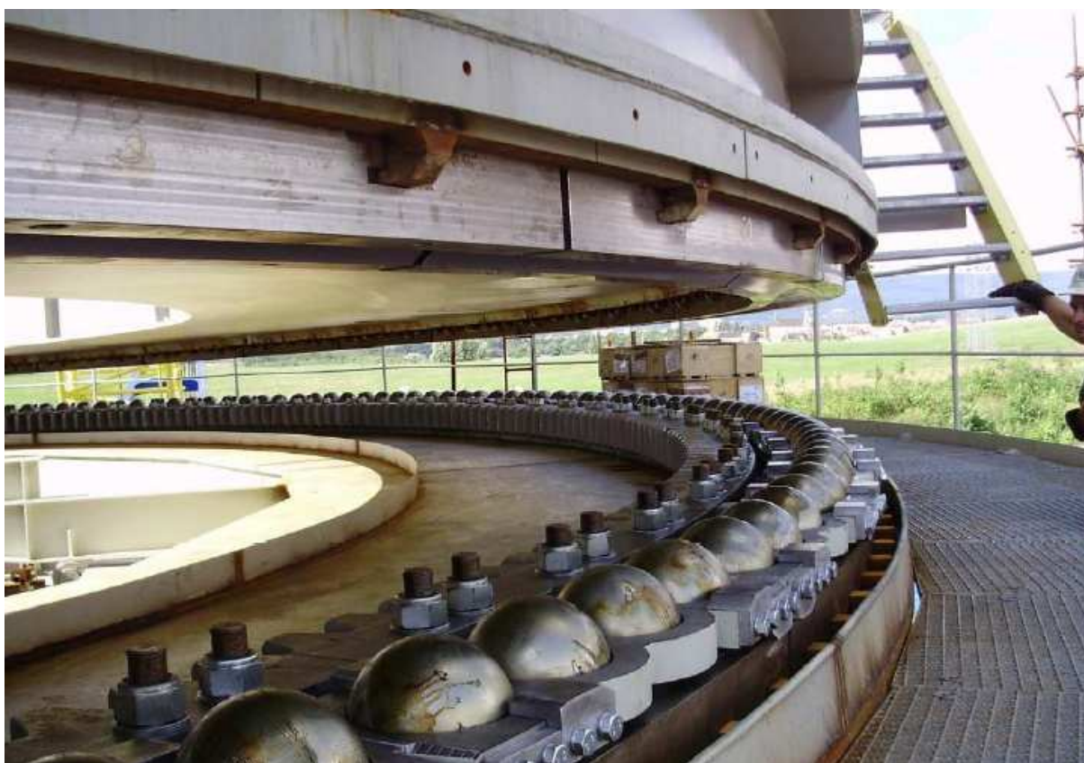
Obr. 18 Detail kulové dráhy [33]
