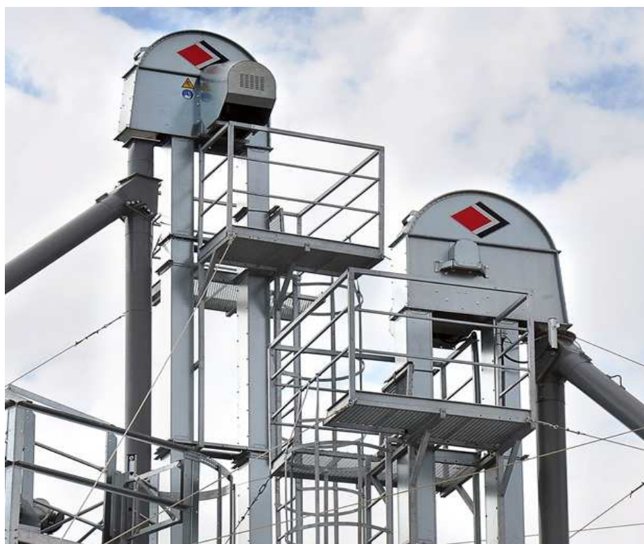
Obr. 14 Elevátorová věž SKANDIA [12]
