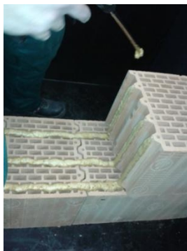
Obr. 28 Zdění druhé vrstvy pomocí PUR pěny
