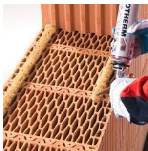
Obr. 14 Zdění na PUR pěnu [61]
