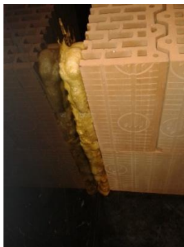
Obr. 29 Nedoléhající strana vyplněna zdicí pěnou
