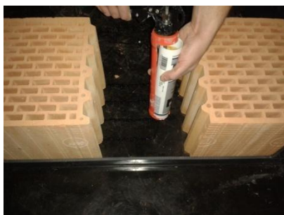
Obr. 27 První vrstva založená na střešním tmelu
