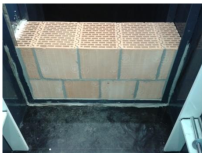
Obr. 31 Stěna opatřená ochrannými lištami
