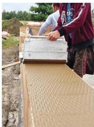
Obr. 13 Zdění na celoplošnou spáru [60]
