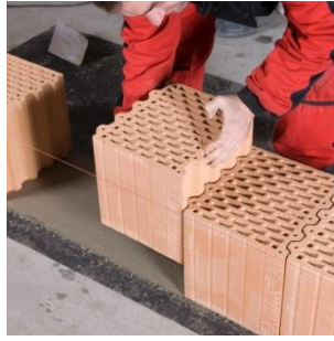
Obr. 11 Zakládání první vrstvy [57]
