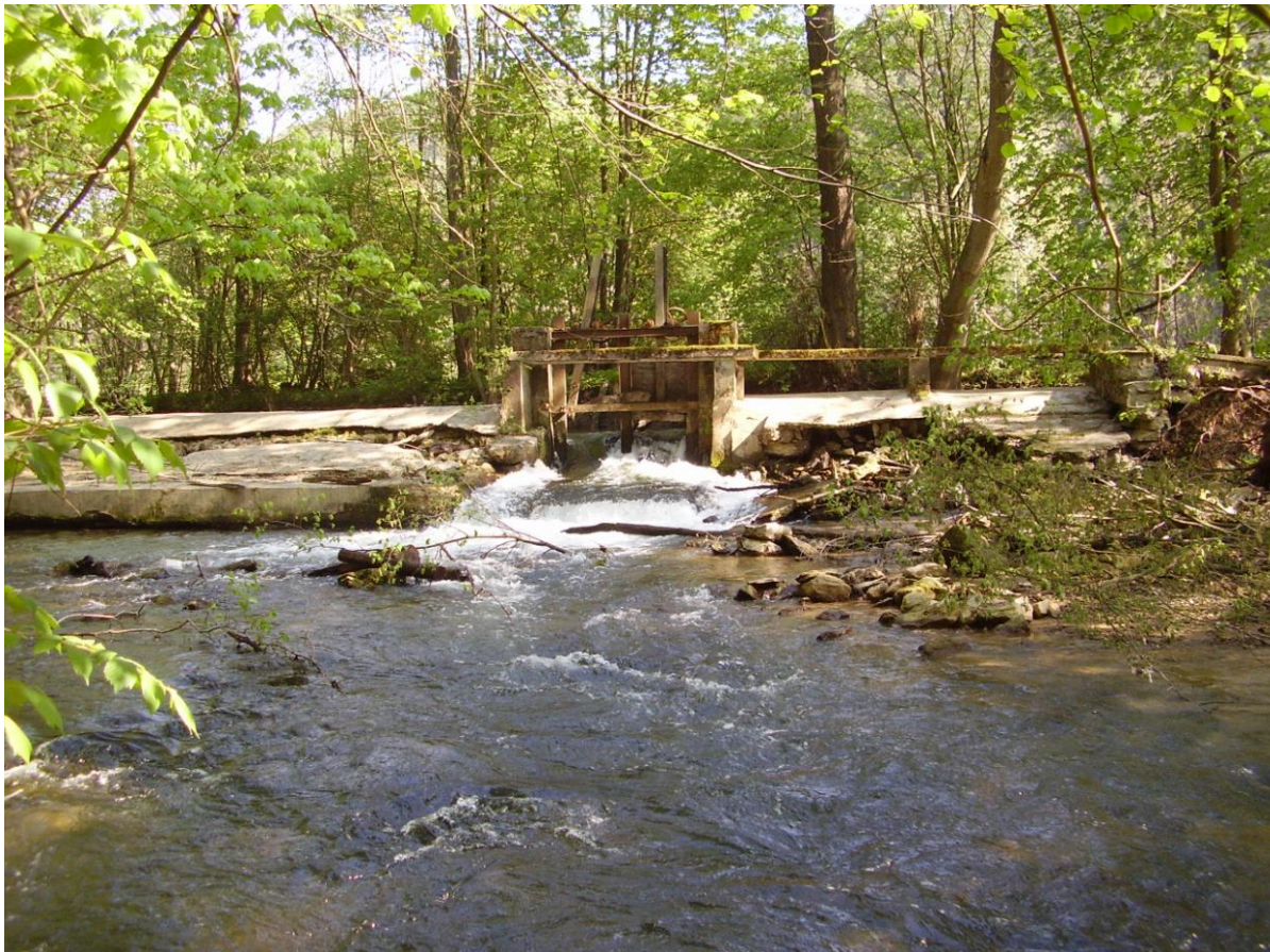
Obrázek 2-1: Stávající jezová konstrukce na km 3,625. Foto Špaček 2011.
