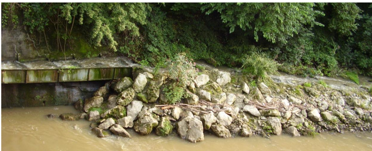
Obrázek 2-17: Přechod z ocelového žlabu do balvanitého koryta. Řeka Rems, Německo. Foto Špaček 2009.
