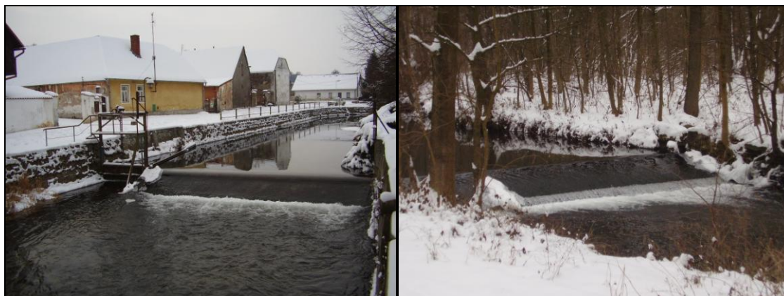
Obrázek 2-2: Vlevo jez na km 0,512. Vpravo jez na km 1,157. Foto Špaček 2012.
