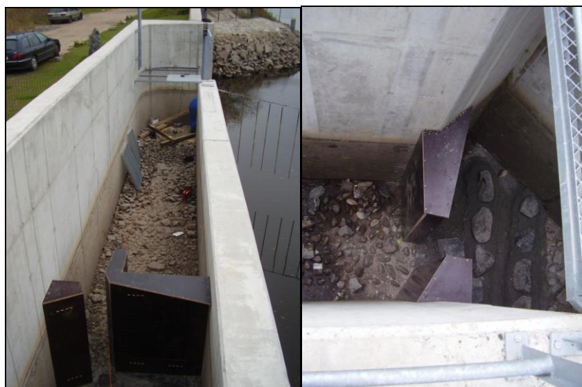
Obrázek 2-21: Úpravy šterbinového přechodu. Stupeň Čelákovice, řeka Labe. Foto Špaček 2012.
