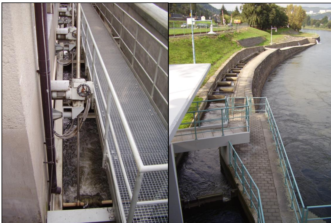
Obrázek 2-19: Komůrkový rybí přechod. Stupeň Střekov, řeka Labe. Foto Špaček 2011.
