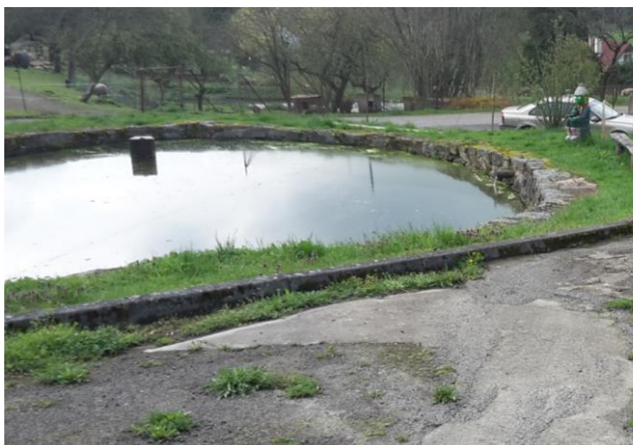
Obr. 9.8 Retenční nádrž v centru obce Lísky, (vlastní zdroj)
