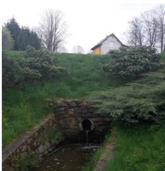
Obr. 9.11 Odtok z retenční nádrže u rodinného domu v obci Lohenice, (vlastní zdroj)
