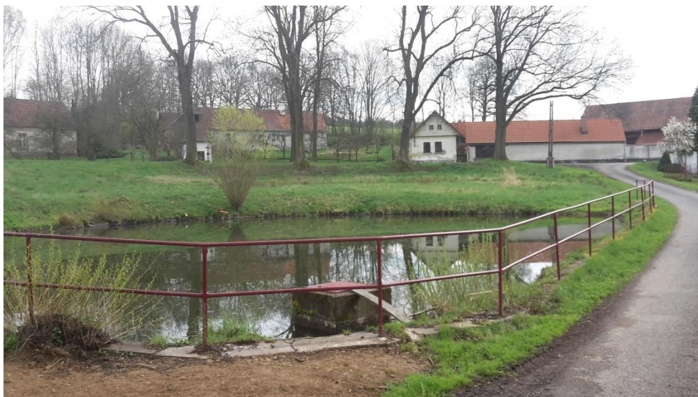
Obr. 9.10 Stávající retenční nádrž s odtokem do odvodňovacího příkopu v obci Lohenice, (vlastní zdroj)
