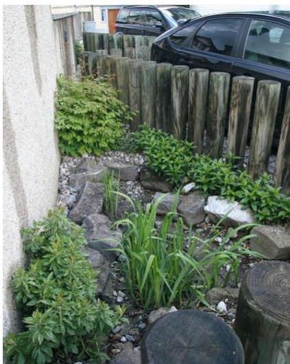
Obr. 5.2 Zasakovací průleh v centru obce, [13]
