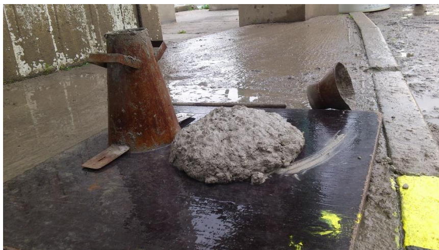
Obrázek 53 – Měření konzistence betonu [20]
