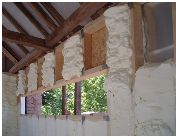
Obrázek 8: Aplikace PUR pěny [37]
