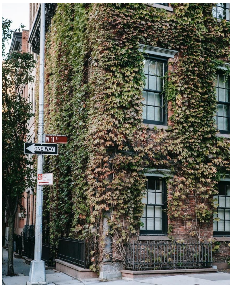
Obr. 17 – zelená fasáda na vícepodlažním objektu – zdroj: Pexels.com
