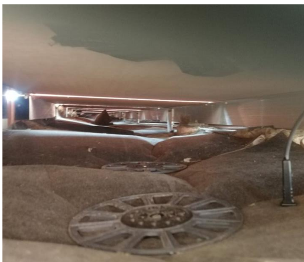
Obr. 41 – pohled ze vstupního otvoru dovnitř vzduchové dutiny tlusté zhruba 120 mm, zdroj: fotodokumentace výzkumného týmu
