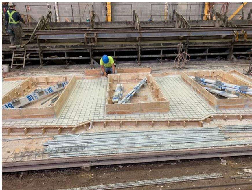
Obr. 29 – bednění a armování pro fasádní panel ve výrobě [24]
