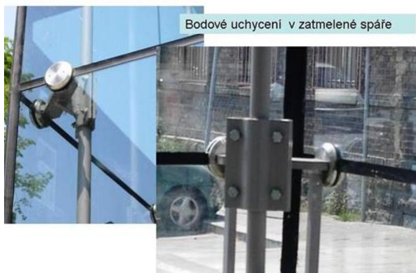
Obr. 21 – bodové uchycení dílu [17]
