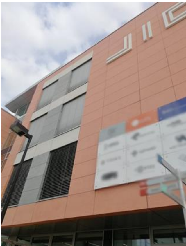
Obr. 22 – realizovaná větraná fasáda na budově JIC v Brně, zdroj: fotodokumentace výzkumného týmu
