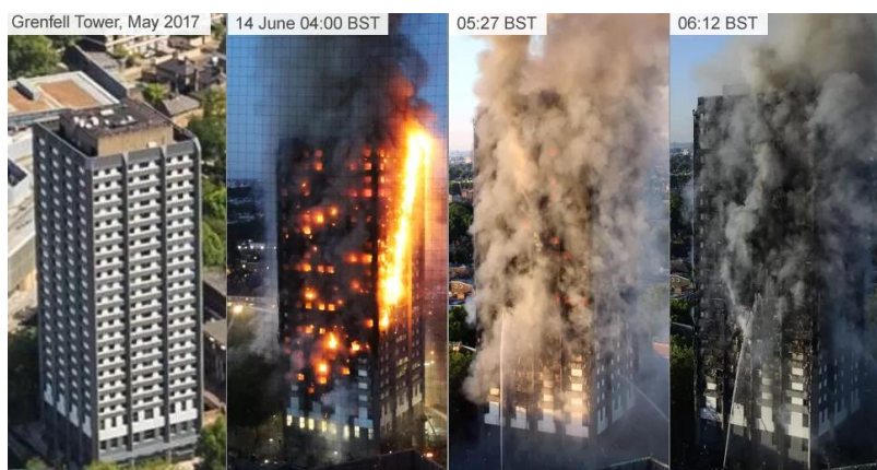
Obr. 25 – Grenfell Tower při požáru [21]
