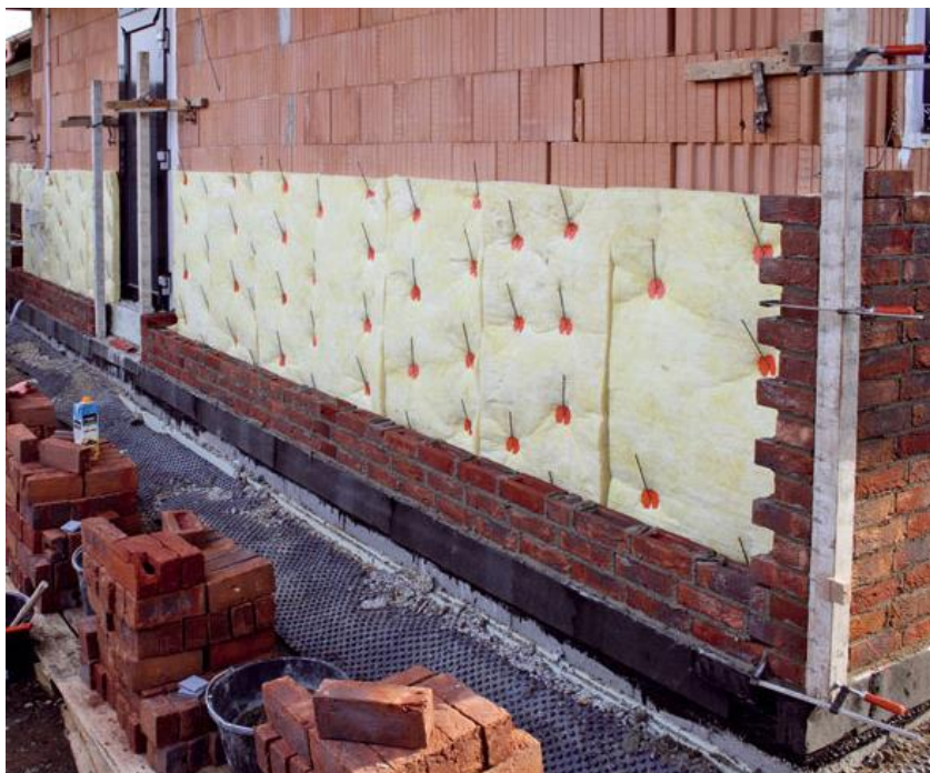
Obr. 13 – příklad realizace sendvičového zdiva [13]
