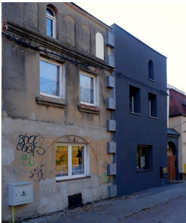
Obr. 2 – dvojdom s půlkou fasády v originálním stavu a s půlkou po zateplení polystyrenovými deskami [4]
