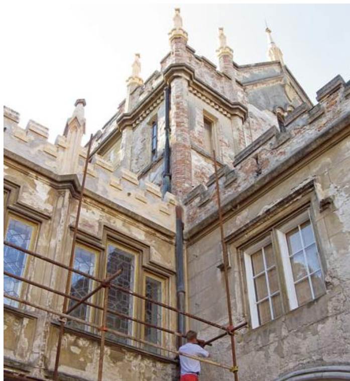
Obr. 1 – práce na restaurování omítky historické budovy [2]
