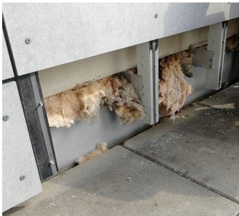
Obr. 42 – bližší pohled na systém nosucí obkladové panely, které jsou přichyceny nýty, zdroj: fotodokumentace výzkumného týmu
