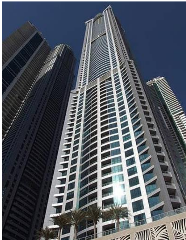
Obr. 26 – ACP použité na The Torch Tower – Dubai (budova s děsivě příhodným názvem také vyhořela) [22]
