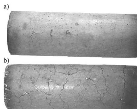
Obr 3.17 Viditelné trhliny na povrchu vzorků po zahřívání na 600 °C, a) HPC s vápencovým kamenivem, b) HPC s křemičito-vápencovým kamenivem [24]
