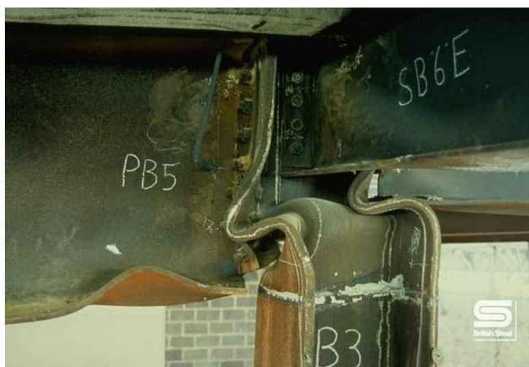
Obr. 4.1 Deformace styčnicku ocelové konstrukce (požární zkouška v Cardingtonu) [42]
