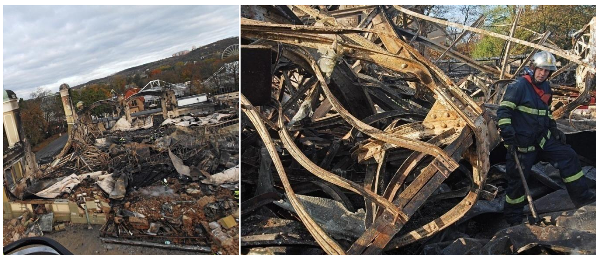
Obr. 4.2 Pražský Průmyslový palác po požáru (rok 2008) [43]
