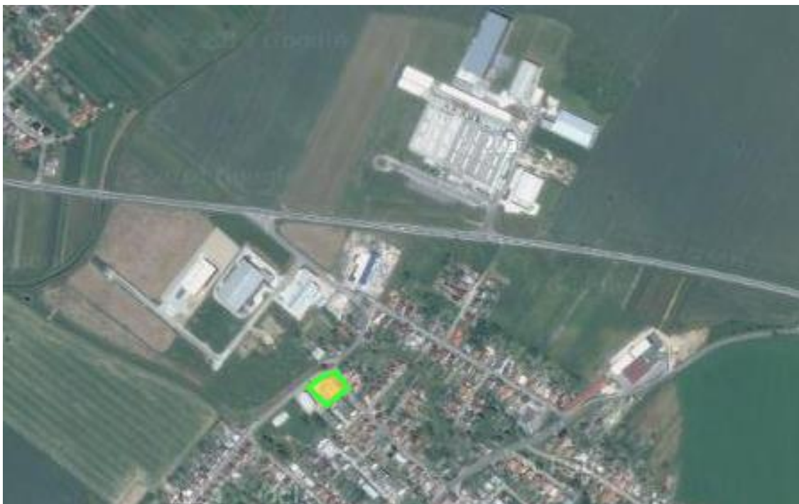
Obrázok 6 - 2 Lokalita bytového domu Sedličná [Zdroj: MONOLIT Slovakia s.r.o.]
