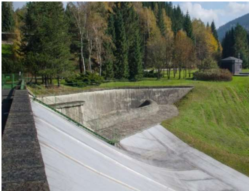
obr. 5.21 Ukázka navrženého typu bezpečnostního přelivu – VD Morávka před rekonstrukcí [22]
