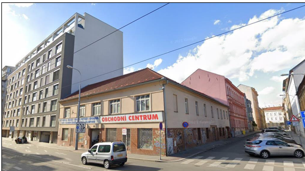
Obr. č. 4: Řešený objekt č.p. 1913 [41]
