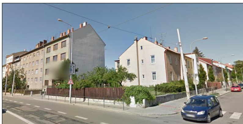
Obr. č. 17: Křižovatka ulic Merhautova a Alešova – místo zamýšleného projektu [41]
