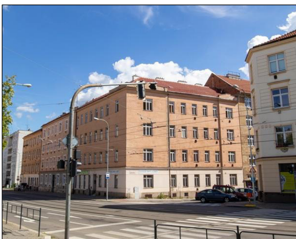
Obr. č. 11: Residence Auerswaldova – před rekonstrukcí [29]
