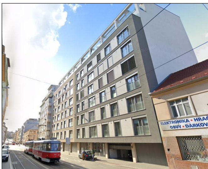
Obr. č. 22: Rezidence Milada I a II – po výstavbě [41]
