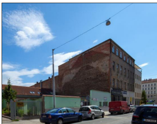
Obr. č. 9: Ponávka Tower – před rekonstrukcí [28]
