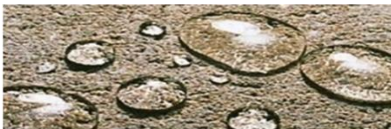
Obrázek 10 - Povrch opatřený hydrofobní impregnací [22]
