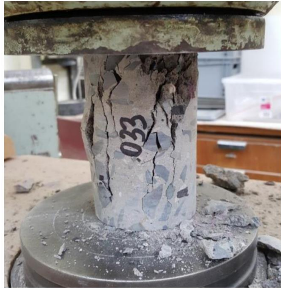
Obrázek 5 Příklad porušení zkušebního tělesa [16]
