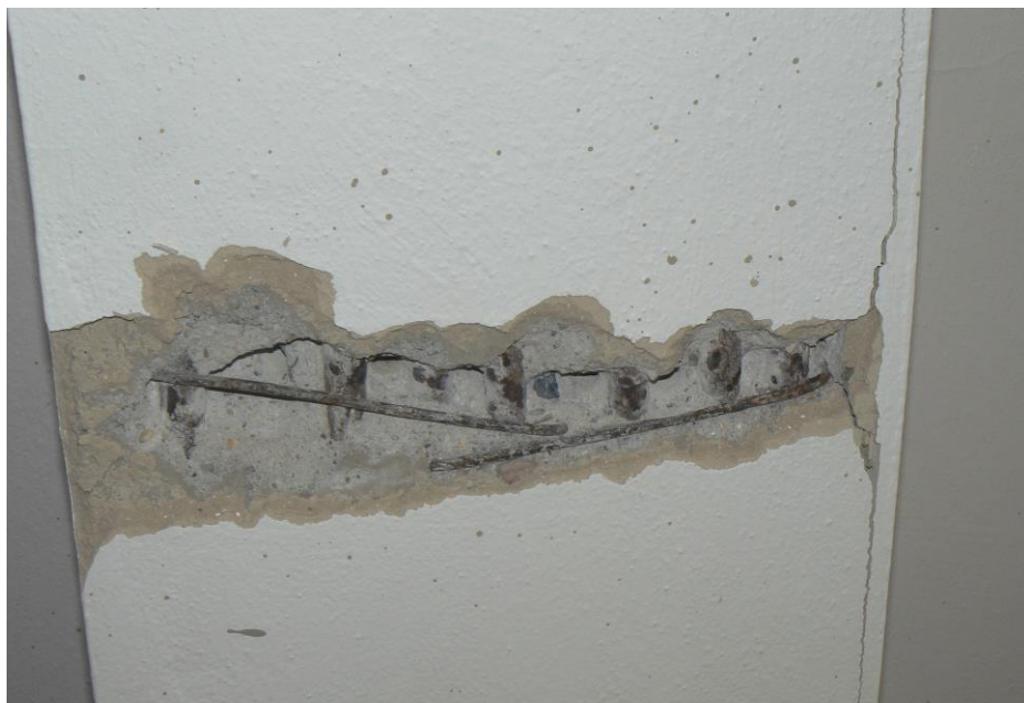
Obrázek 57 Sekaná sonda provedená na spodním líci průvlaku P1-1 v polovině rozpětí
