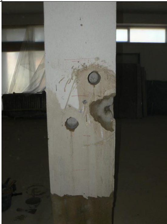
Obrázek 37 Pohled na sloup S1-1 na místo odebraných vývrtů V3 a V4
