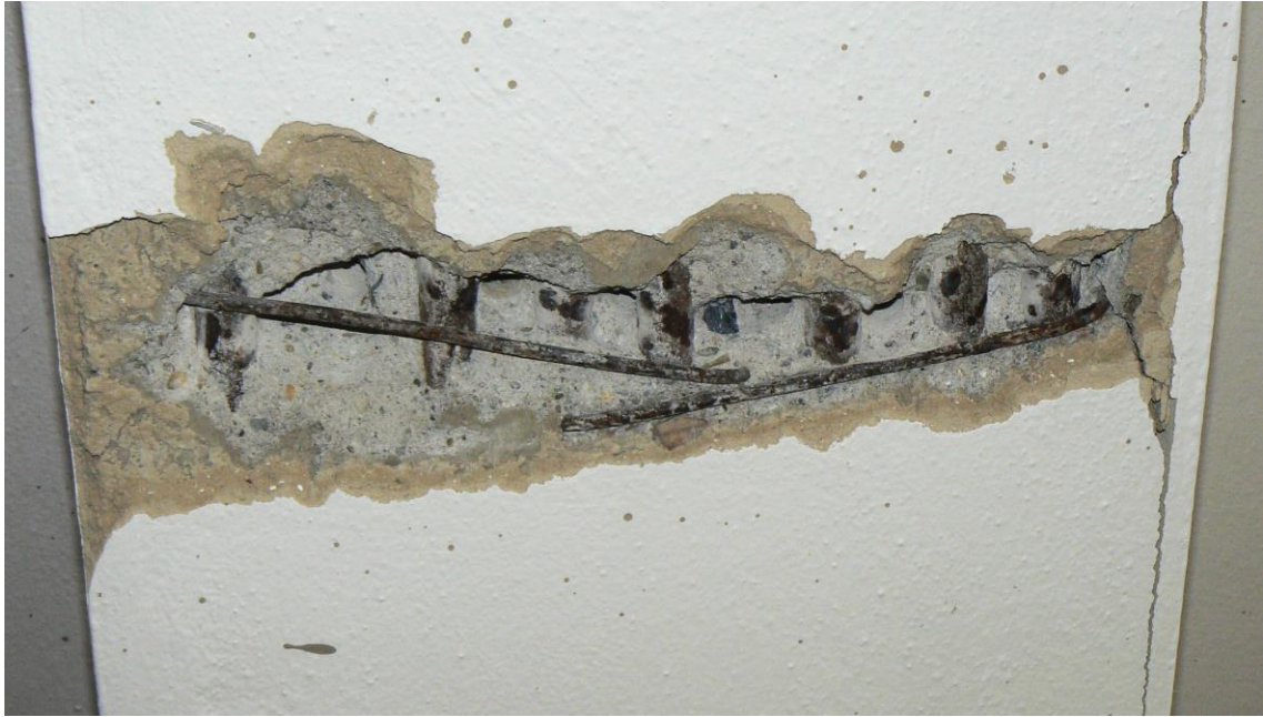
Obrázek 28 Foto provedené sekané sondy na spodním líci průvlaku z důvodu zjištění výztuže
