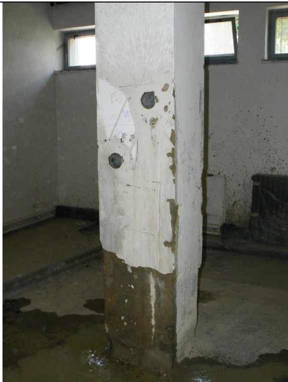
Obrázek 40 Pohled na sloup S1-2 s odebranými vývrti V5 a V6
