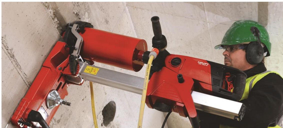
Obrázek 1 Znárodnění odběru jádrového vývrty [14]
