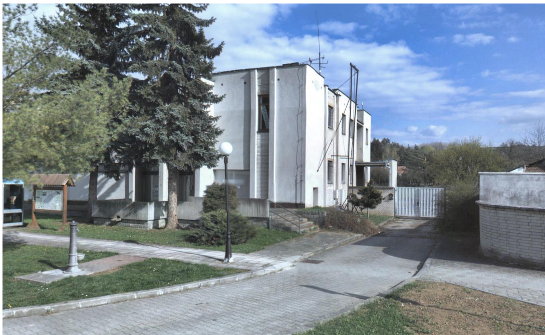
Obrázek 34 Pohled na zkoumaný objekt
